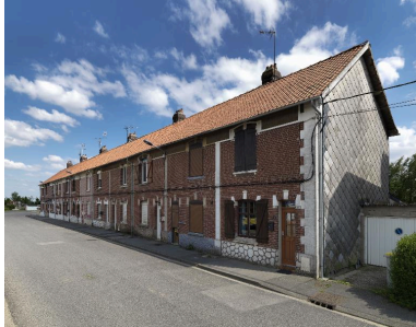
Vue de trois-quarts. Phot. Thierry Lefébure IVR22_20158000434NUC2A
