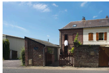
Détail d'un des logements de la cité ouvrière et de sa boutique. Phot. Thierry Lefébure IVR22_20148000454NUC2A
