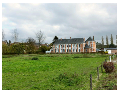
Vue de situation, depuis le nord. Phot. Thierry Lefébure IVR22_20128001027NUC2A
