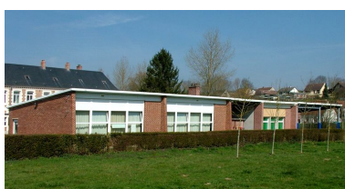
Bâtiment de classes. Phot. Frédéric Fournis IVR22_20118001119NUCA
