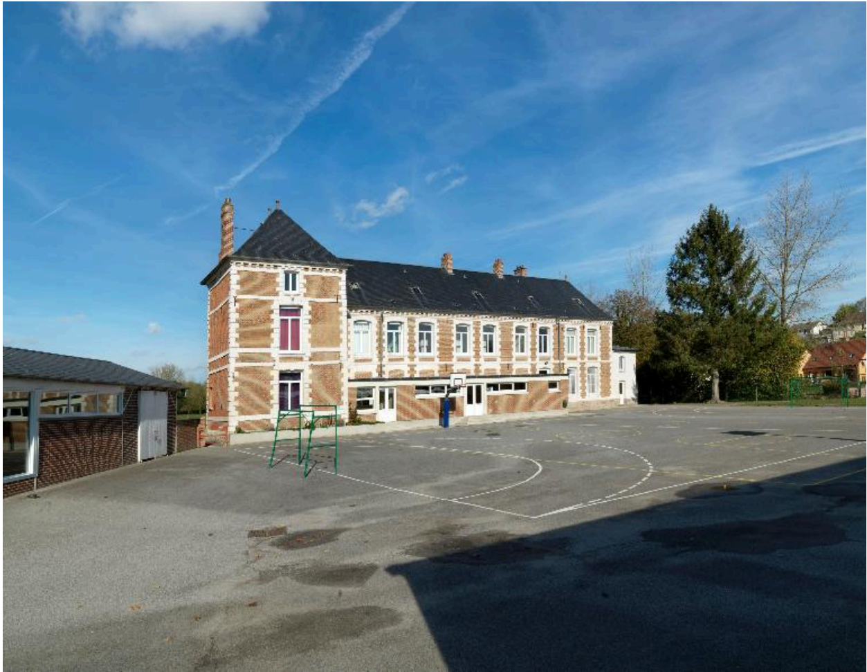
Vue générale depuis la cour.
