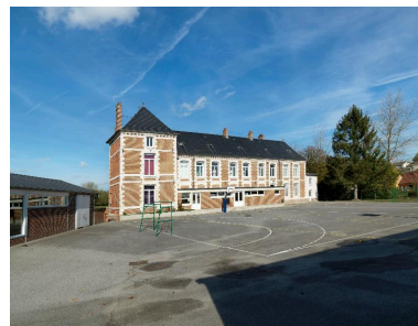
Vue générale depuis la cour. Phot. Thierry Lefébure IVR22_20128001026NUC2A
