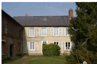
Façade antérieure est. Phot. Thierry Lefébure IVR22_20038000255NUCA
