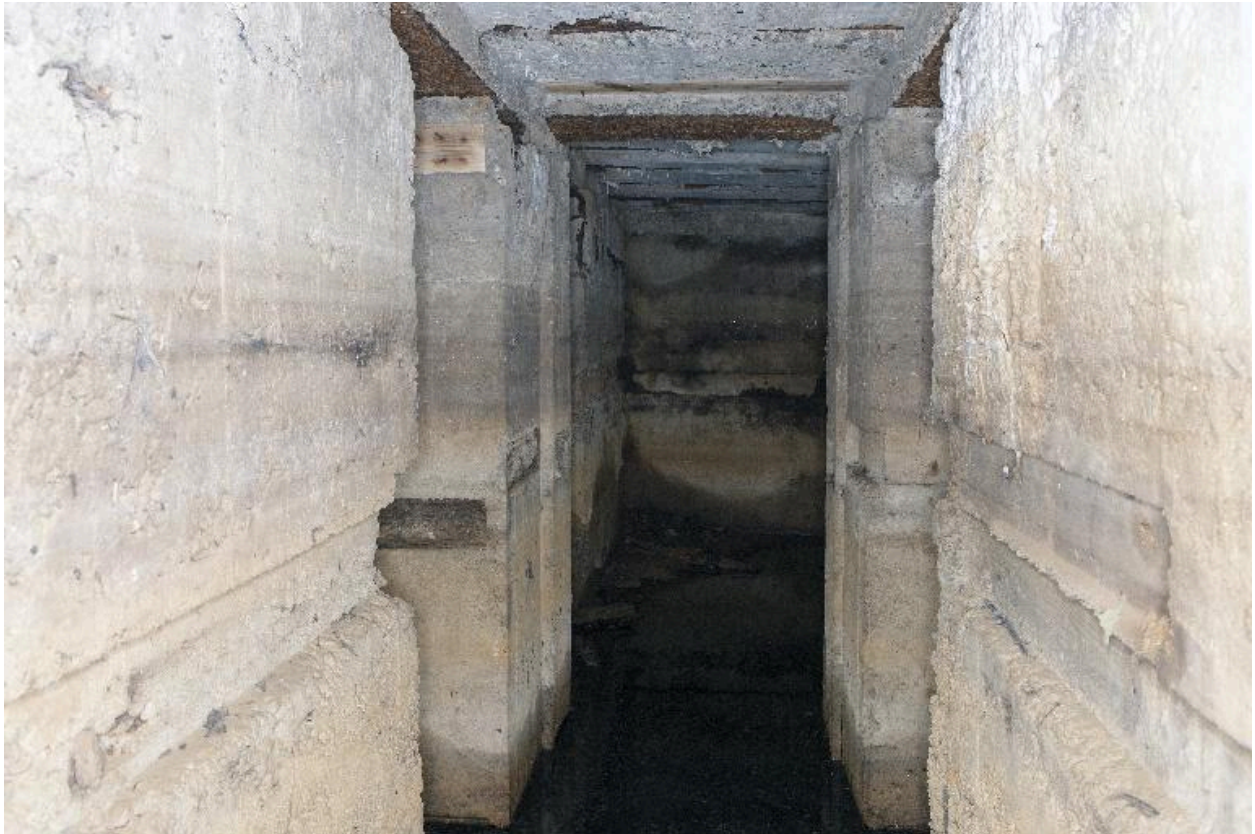
Couloir C2 vers la salle S4
