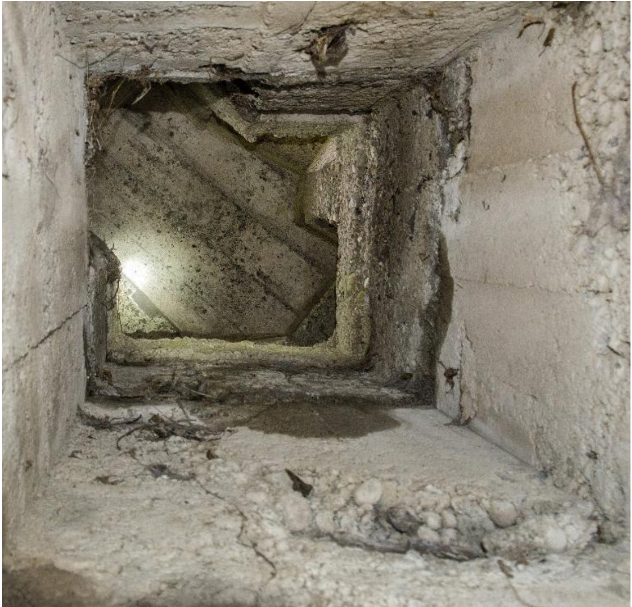
Salle S8, intérieur de la tour de communication optique. Vue zenithale
