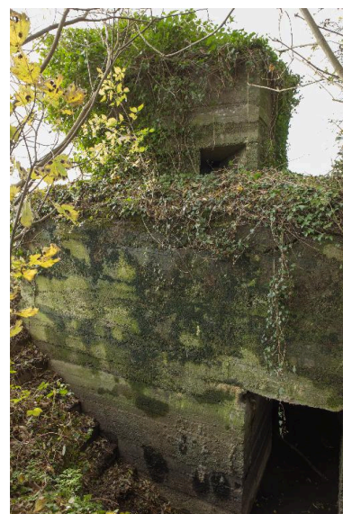
Elévation sud-est. A gauche l'escalier d'accès à la cour sud et entrée de la casemate de communication optique (Salle S8) Phot. Jean-Marc Ramette IVR31_20145904780NUCA
