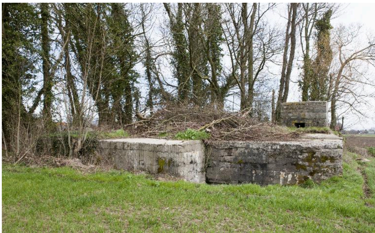
Vue générale vers le nord-est
