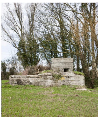
Vue générale vers le nord-ouest après élagage Phot. Pierre Thibaut IVR32_20165900588NUCA
