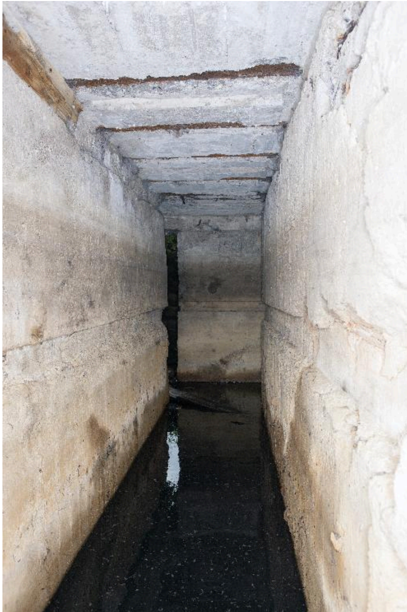
Vue en enfilade du couloir C3, vers le sud
