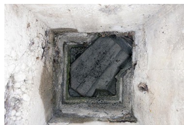
Salle S8, intérieur de la tour de communication optique. Vue zenithale Phot. Jean-Marc Ramette IVR31_20155901432NUCA
