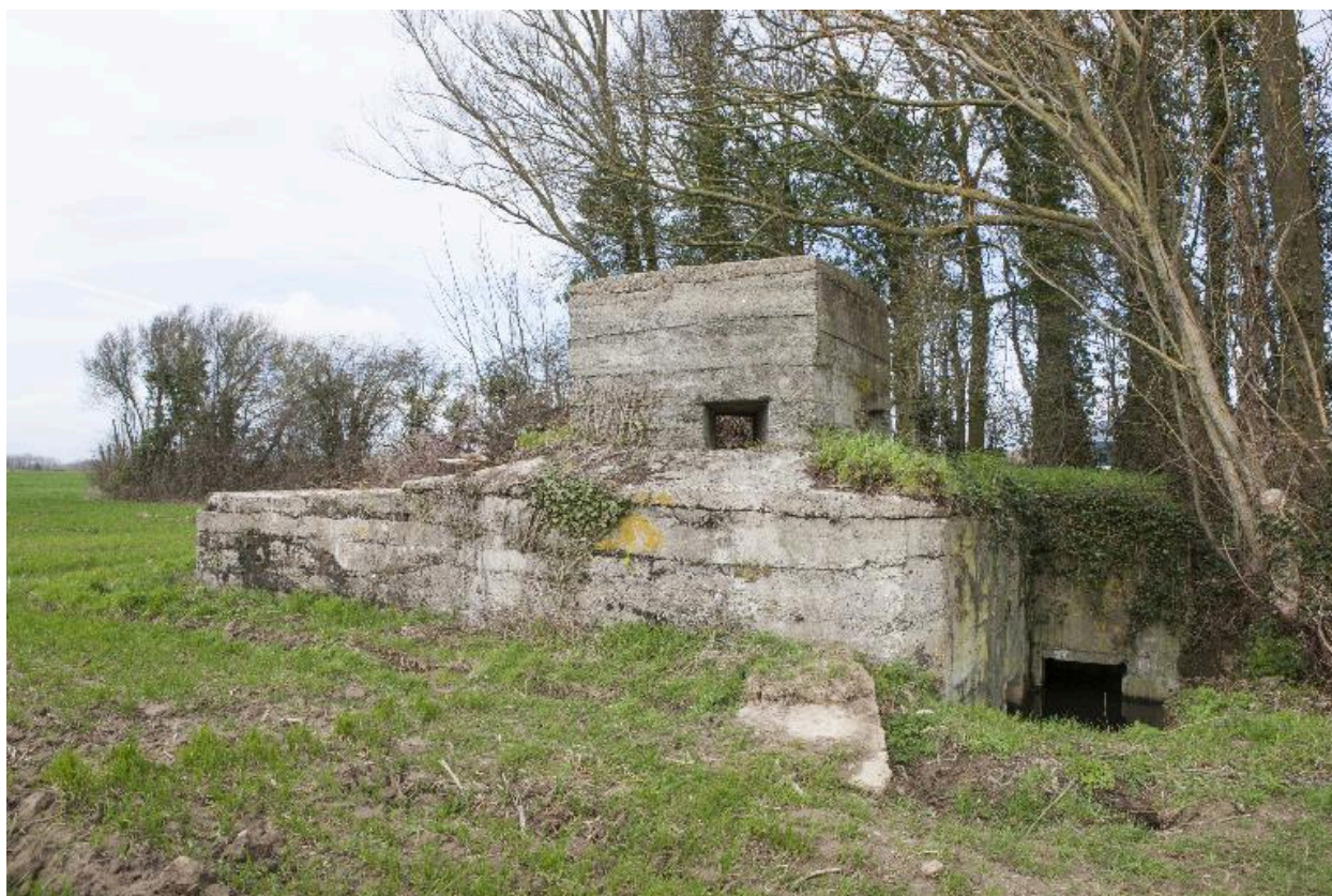
Vue générale, vers le nord-ouest
