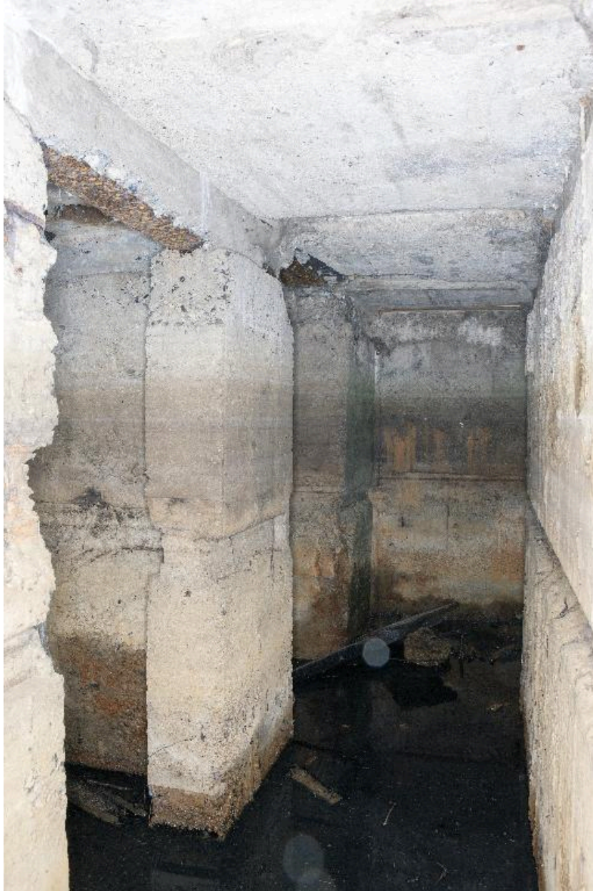
Entrée de la salle S5 depuis le couloir C1
