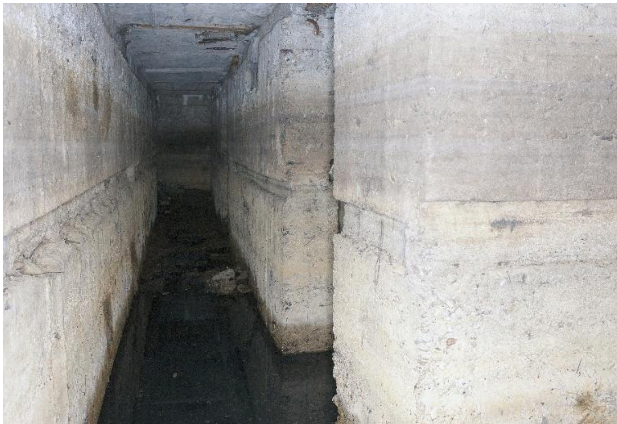
Vue en enfilade du couloir C1, vers l'ouest
