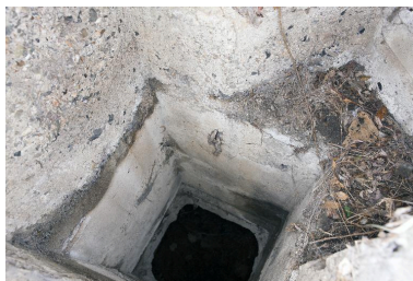
Intérieur de la tour de communication optique, vers le bas Phot. Pierre Thibaut IVR31_20155901434NUCA
