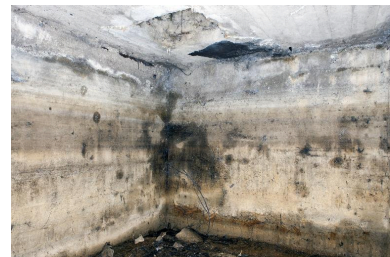
Salle S8, accès à la tourelle de communication optique Phot. Pierre Thibaut IVR31_20155901431NUCA
