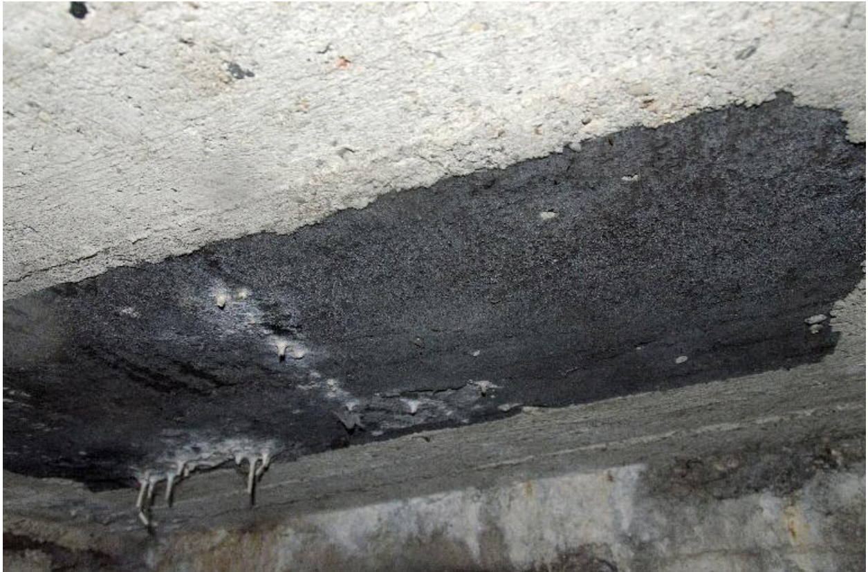
Salle S8, plaque métallique au plafond
