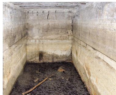
Salle S5 depuis le couloir C1 Phot. Jean-Marc Ramette IVR32_20175900527NUCA
