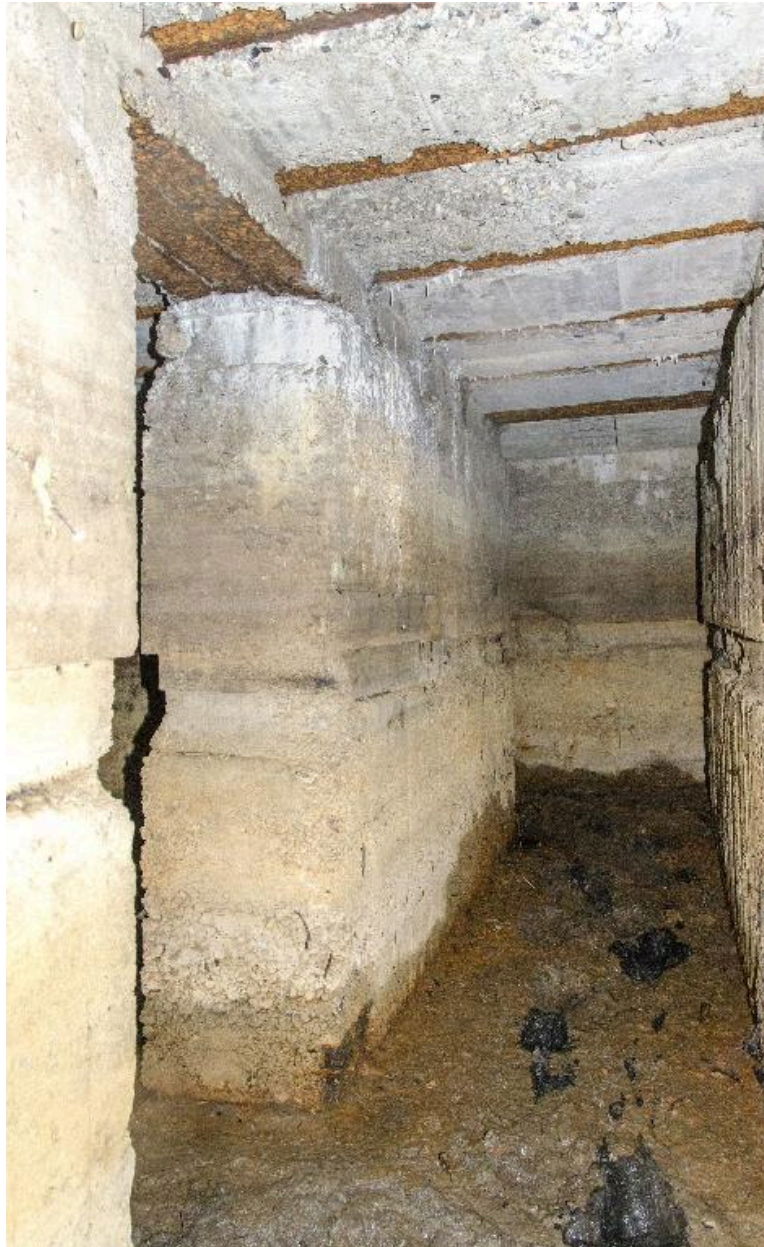
Couloir C2 en enfilade. Au fond la salle S4
