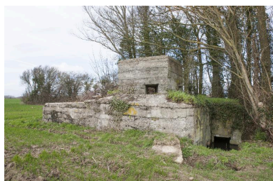
Vue générale, vers le nord-ouest Phot. Pierre Thibaut IVR32_20165900586NUCA
