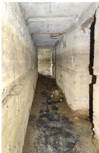
Couloir C1. Vue en enfilade vers l'ouest. Phot. Jean-Marc Ramette IVR32_20175900520NUCA
