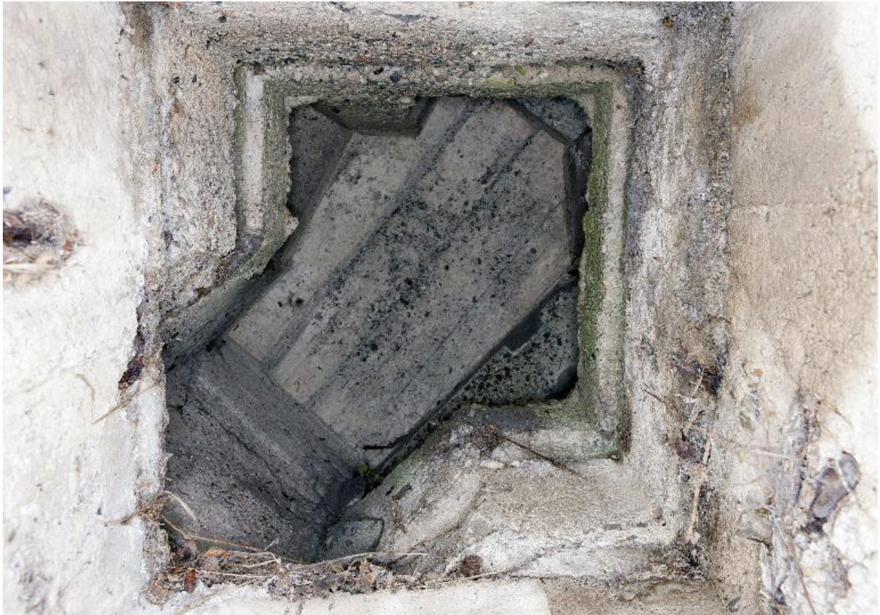
Salle S8, intérieur de la tour de communication optique. Vue zenithale
