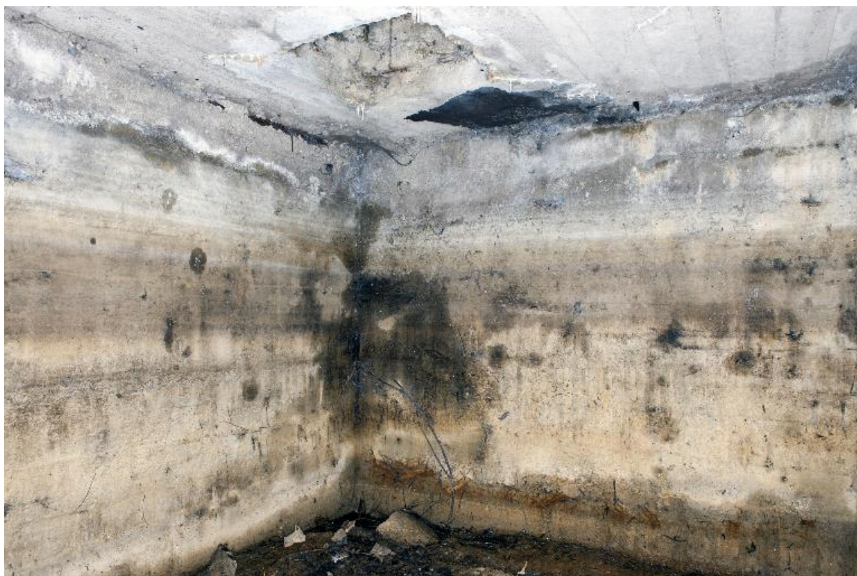
Salle S8, accès à la tourelle de communication optique
