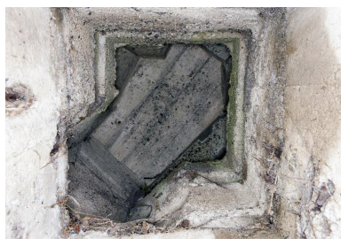
Salle S8, intérieur de la tour de communication optique. Vue zenithale Phot. Pierre Thibaut IVR31_20155901433NUCA
