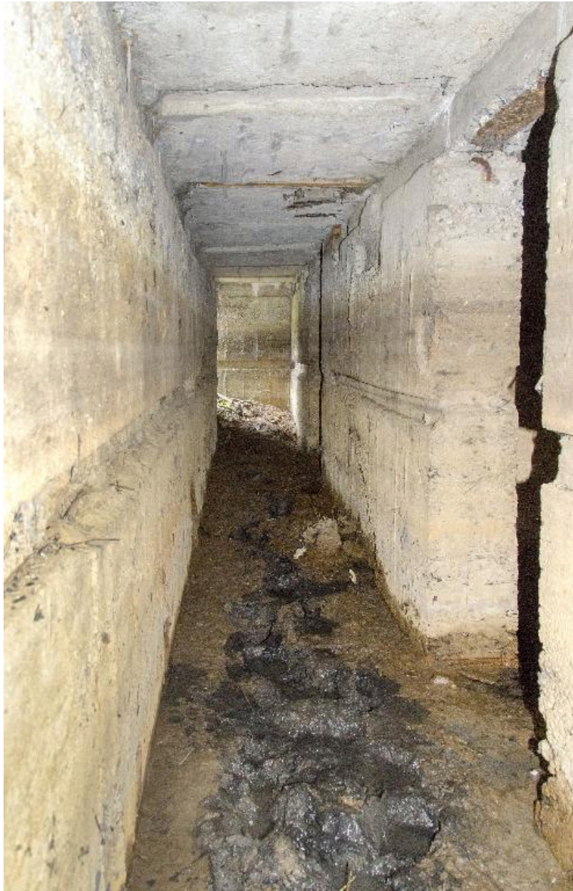
Couloir C1. Vue en enfilade vers l'ouest.
