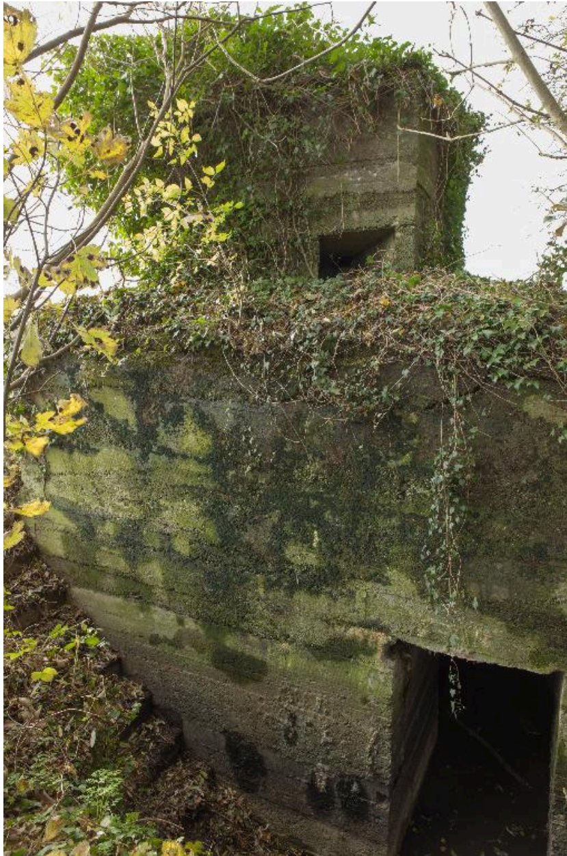
Elévation sud-est. A gauche l'escalier d'accès à la cour sud et entrée de la casemate de communication optique (Salle S8)
