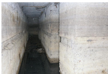
Vue en enfilade du couloir C1, vers l'ouest Phot. Pierre Thibaut IVR31_20155901423NUCA
