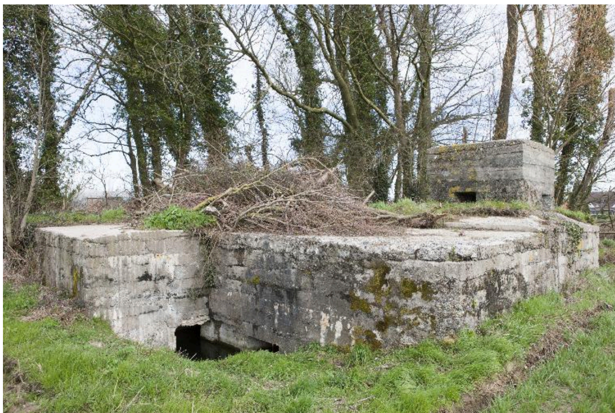
Vue générale vers le nord avec, à gauche, en partie comblé, l'escalier d'accès à la cour nord
