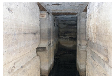
Couloir C2 vers la salle S4 Phot. Pierre Thibaut IVR31_20155901425NUCA
