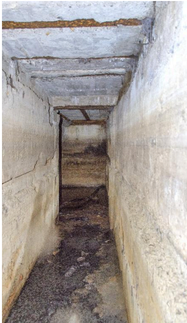
Couloir C3, enfilade vers le nord Phot. Jean-Marc Ramette IVR32_20175900521NUCA
