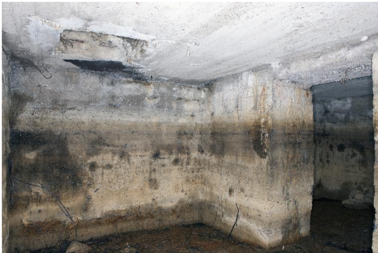
Salle S8 et entrée de la salle S7, à droite
