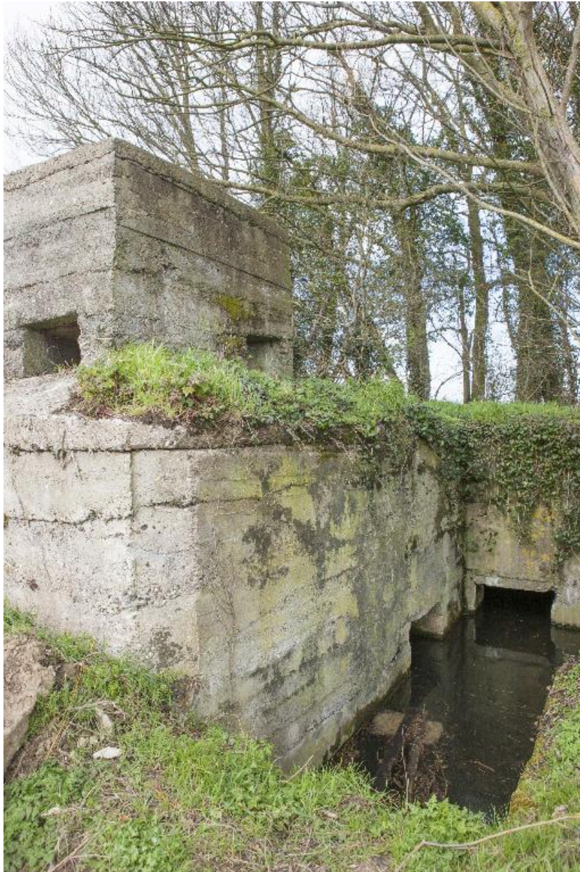
Elévation sud-est vers le nord. A droite l'escalier d'accès à la cour sud (ennoyé).
