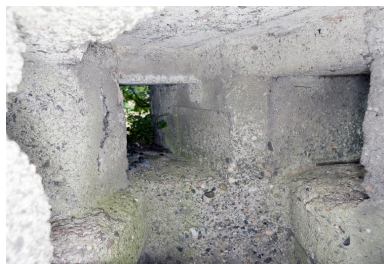
Intérieur de la tour de communication optique. Vue horizontale depuis l'embrasure ouest Phot. Pierre Thibaut IVR31_20155901435NUCA
