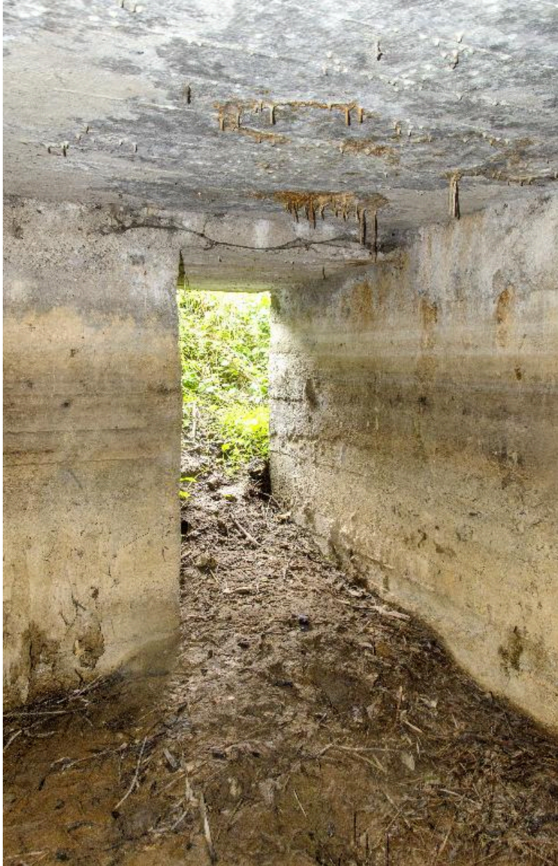
Couloir C1, sortie vers la cour nord
