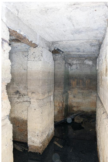
Entrée de la salle S5 depuis le couloir C1 Phot. Pierre Thibaut IVR31_20155901429NUCA
