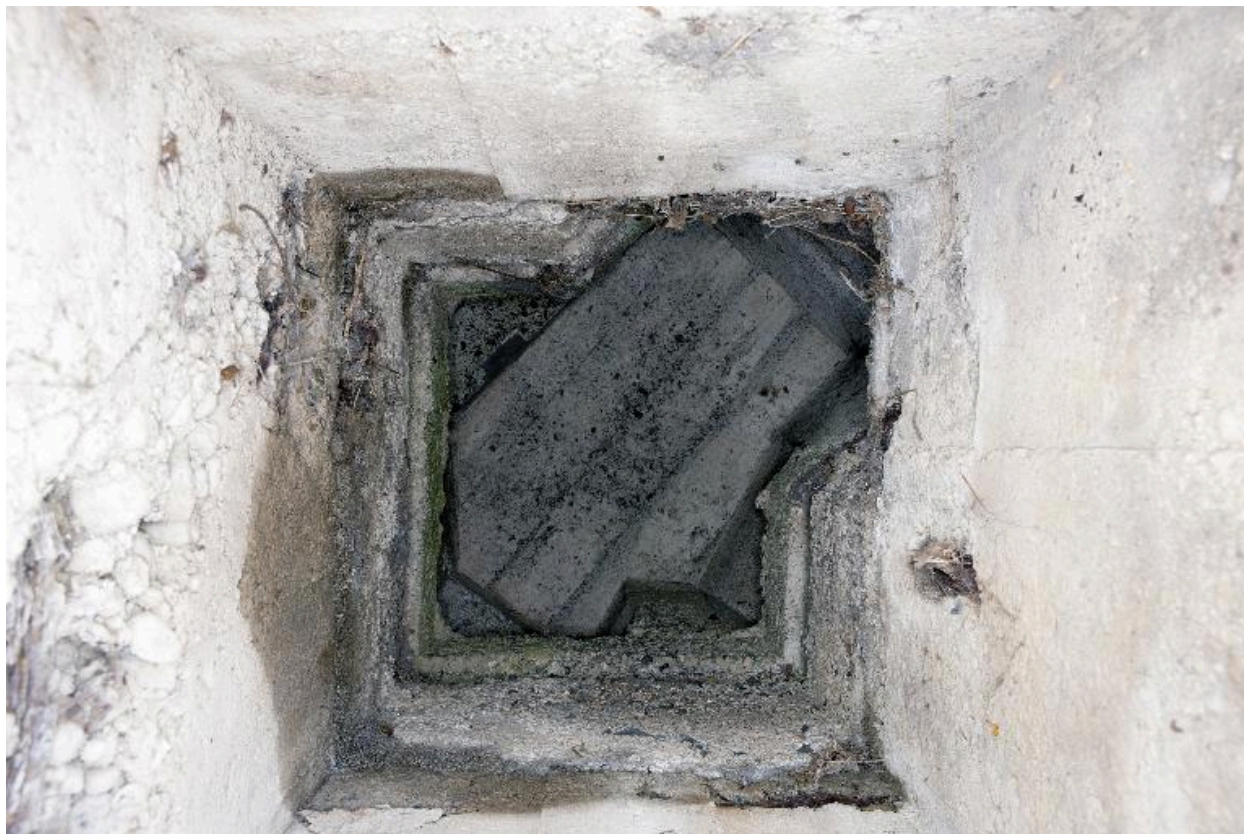
Salle S8, intérieur de la tour de communication optique. Vue zenithale
