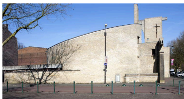
Vue du flanc sud. Phot. Pierre Thibaut IVR31_20155900896NUCA
