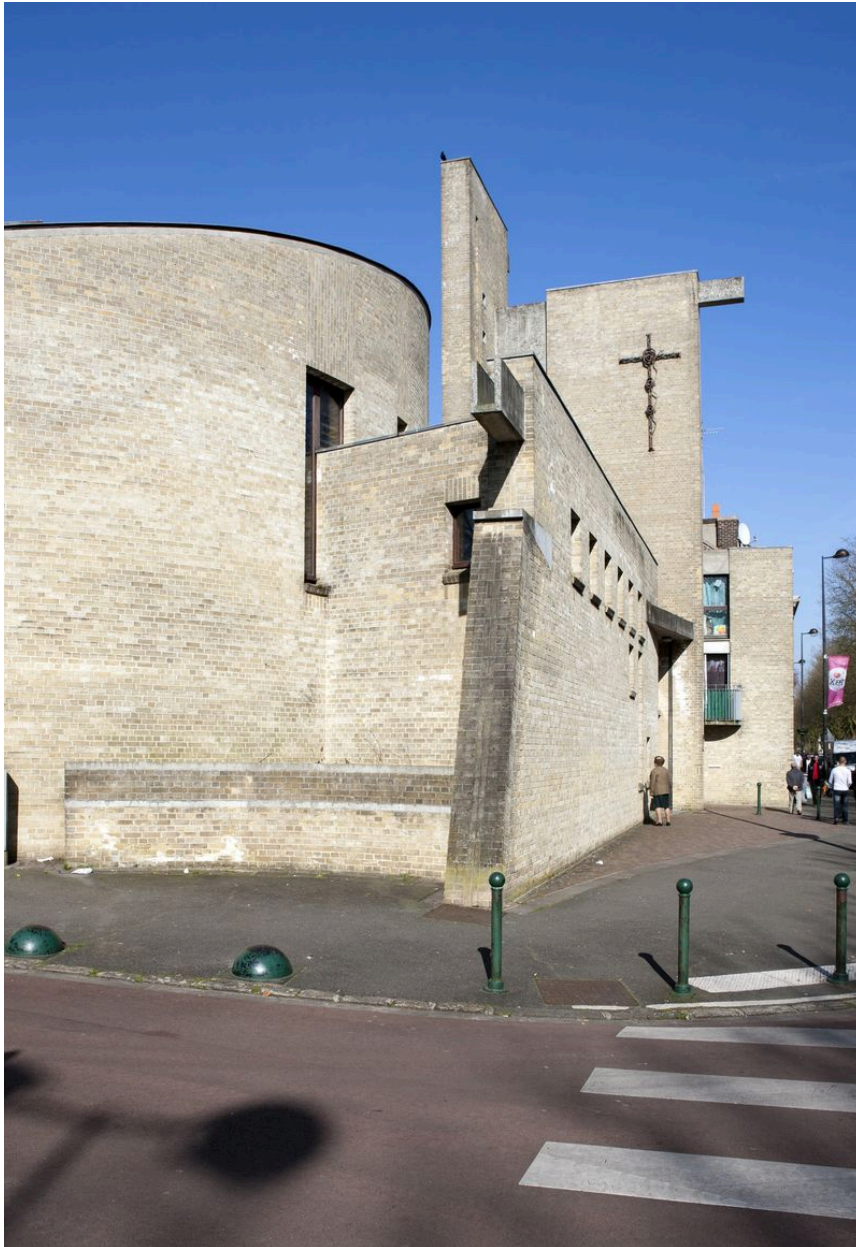
Vue en enfilade de l'élévation antérieure.
