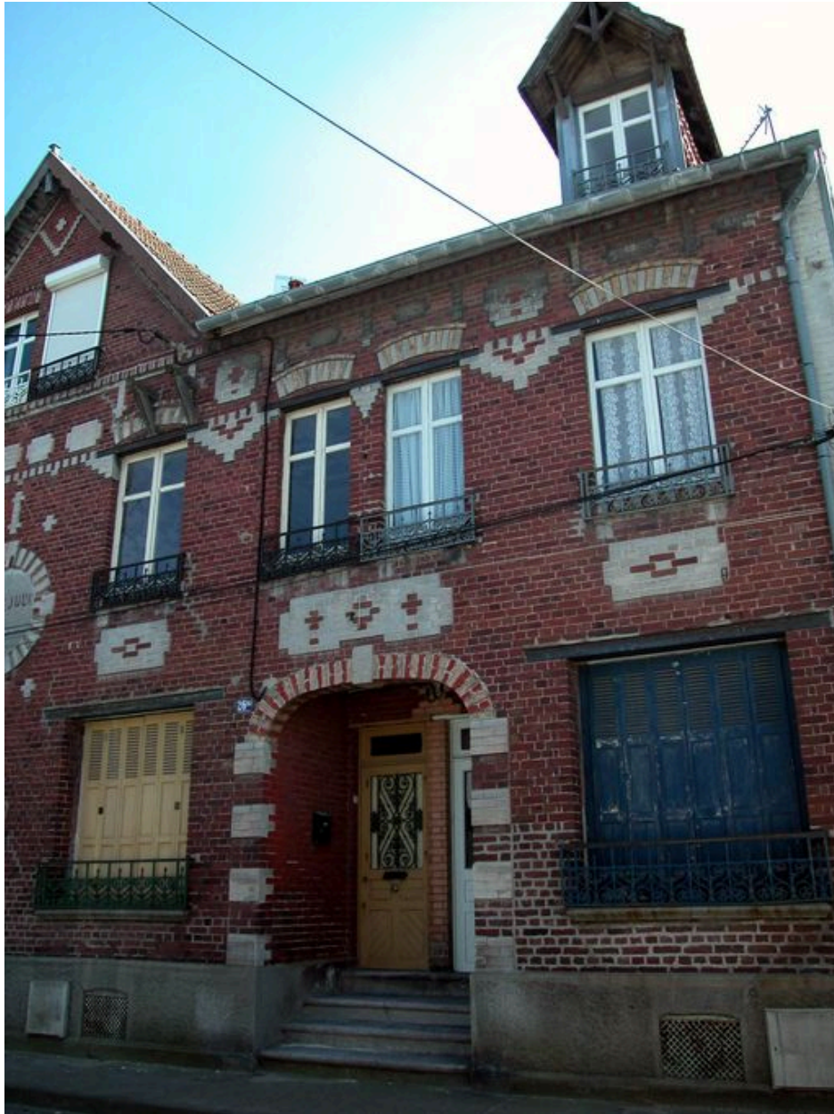
Détail des deux logements de droite.
