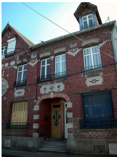
Détail des deux logements de droite.
