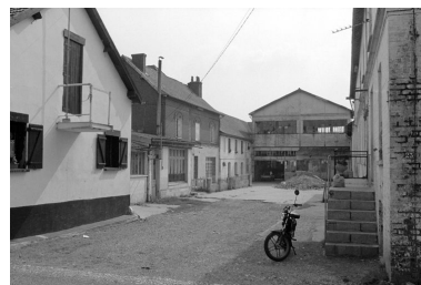
Atelier de fabrication, élévation antérieure. Phot. Francis Dubuc IVR22_19908000754Z
