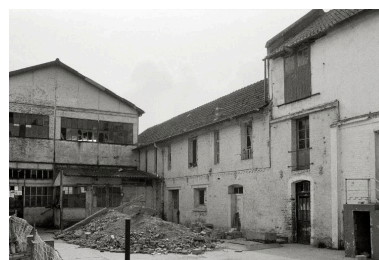
Ateliers vus depuis la cour. Phot. Francis Dubuc IVR22_19908000756Z
