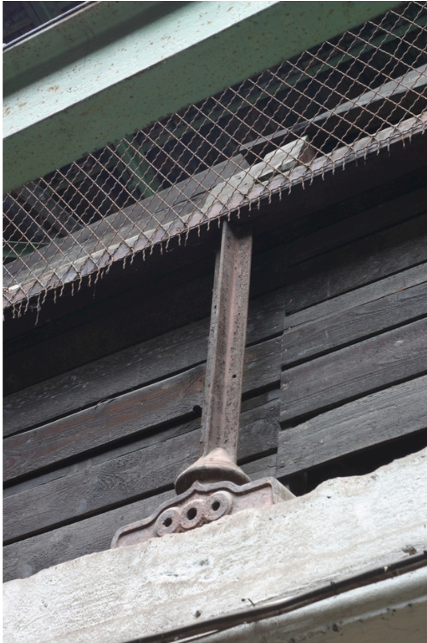
Magasin industriel : détail du garde-corps de la galerie-haute.
