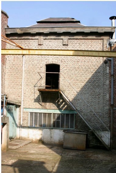
Atelier d'outillage (probablement ancienne forge ou fonderie). Phot. Frédéric Pillet IVR22_20050205254NUCA
