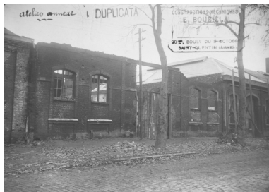
Façade de l'atelier annexe, boulevard Léon Blum. A droite, l'atelier de mécanique. 1919 (AD Aisne). Phot. Pillet Frédéric IVR22_20050205074NUCAB
