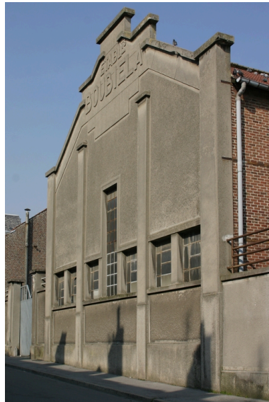
Pignon de l'atelier de montage, rue Voltaire. Phot. Frédéric Pillet IVR22_20050205255NUCA
