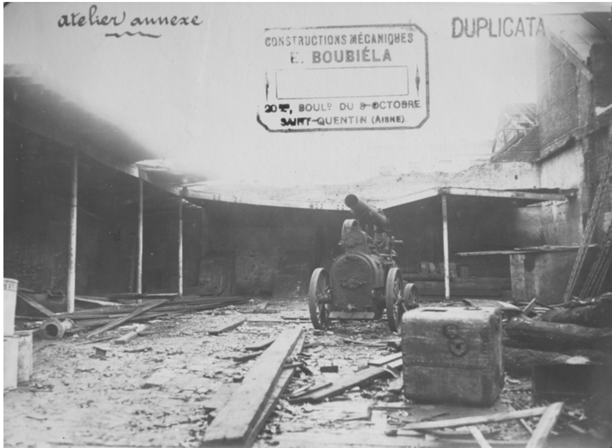
Vue intérieure de l'atelier annexe, où est entreposée une locomobile, 1919 (AD Aisne).
