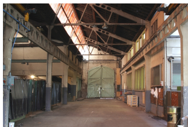
Ancien atelier de mécanique. Phot. Frédéric Pillet IVR22_20050205248NUCA
