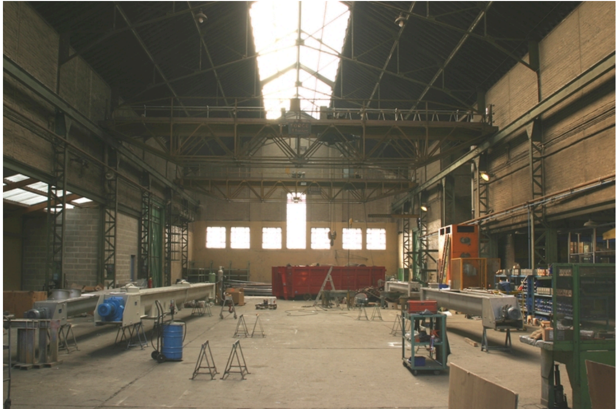
Vue intérieure de l'atelier de montage.
