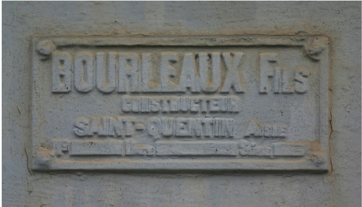
Plaque de constructeur fixée sur la structure métallique du grand hall (daté des années 1919-1924).
