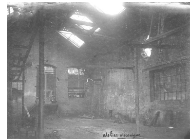
Atelier de mécanique, 1919 (AD Aisne). Phot. Pillet Frédéric IVR22_20050205073NUCAB
