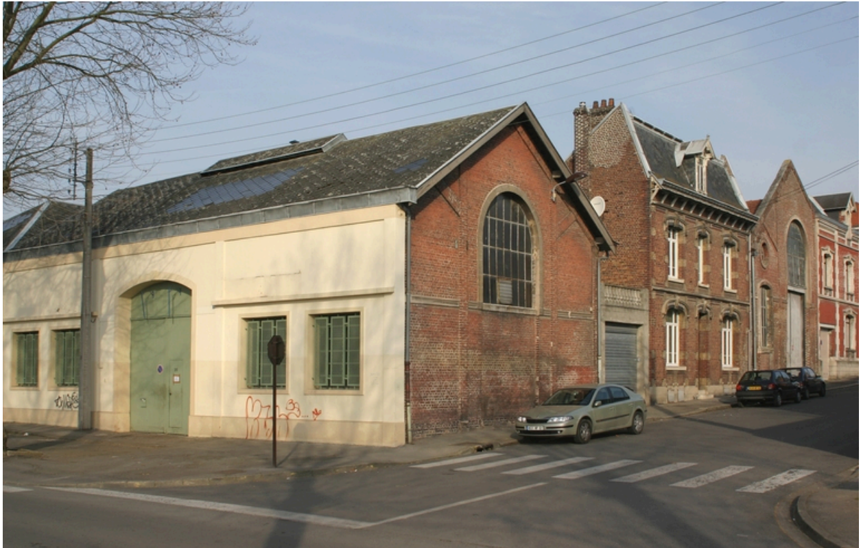
A l'angle de la rue des Patriotes et du Boulevard Léon-Blum, de gauche à droite : atelier, logement patronal et magasin industriel.
