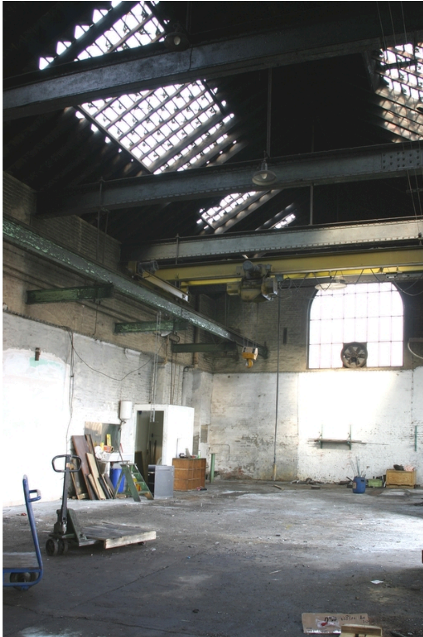
Ancienne chaudronnerie (avant 1914) puis forge et atelier de découpage.
