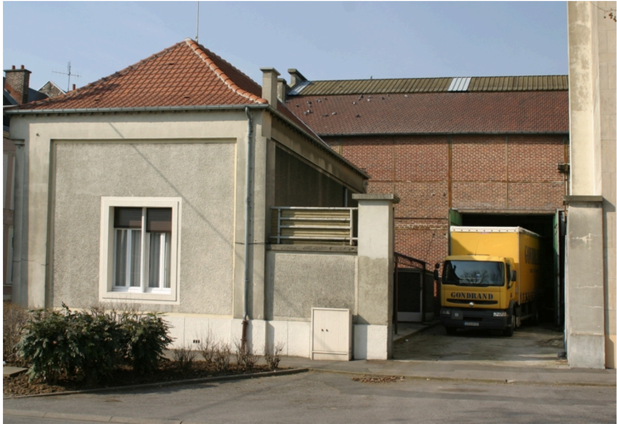
Ancienne conciergerie, et accès à l'atelier de montage.
