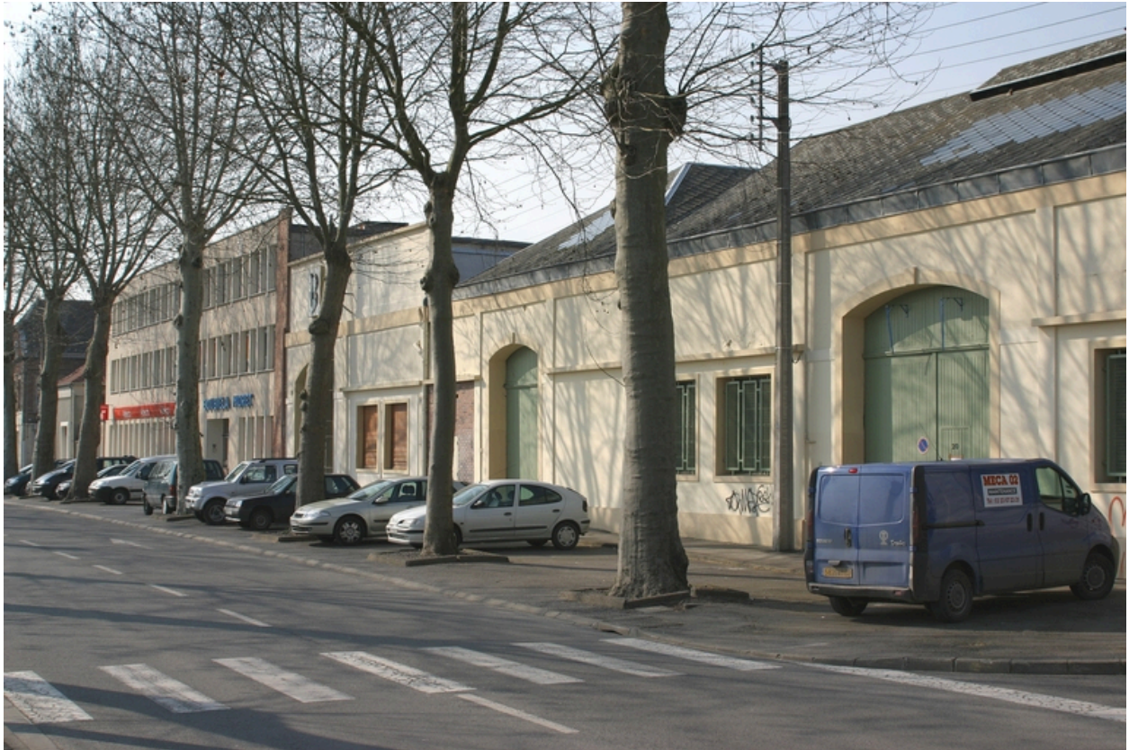
L'usine, boulevard Léon-Blum : de droite à gauche, anciens ateliers de chaudronnerie et de mécanique, bureaux.
