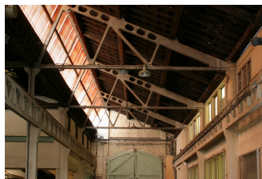
Ancien atelier de mécanique : détail de la structure porteuse et de la charpente, en béton armé. Phot. Frédéric Pillet IVR22_20050205249NUCA
