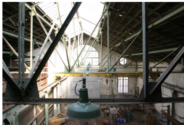
Charpente métallique du magasin industriel.
