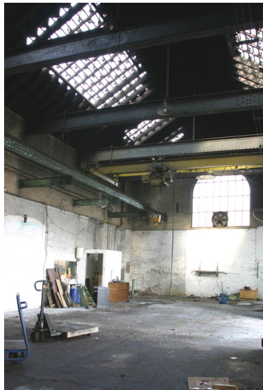
Ancienne chaudronnerie (avant 1914) puis forge et atelier de découpage. Phot. Frédéric Pillet IVR22_20050205245NUCA
