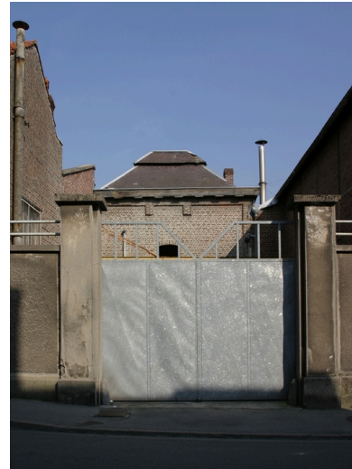
Entrée des ateliers, rue Voltaire : à l'arrière plan, le magasin d'outillage (probablement ancienne forge ou fonderie). Phot. Frédéric Pillet IVR22_20050205253NUCA
