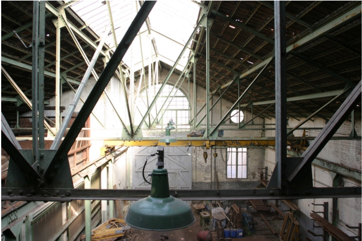
Charpente métallique du magasin industriel.
