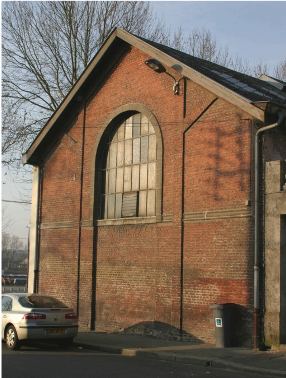
Pignon de l'ancienne chaudronnerie (avant 1914) puis forge et atelier de découpage.
