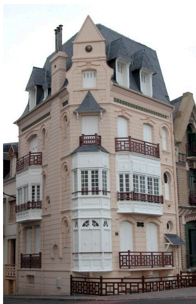
Vue d'ensemble depuis l'esplanade.
