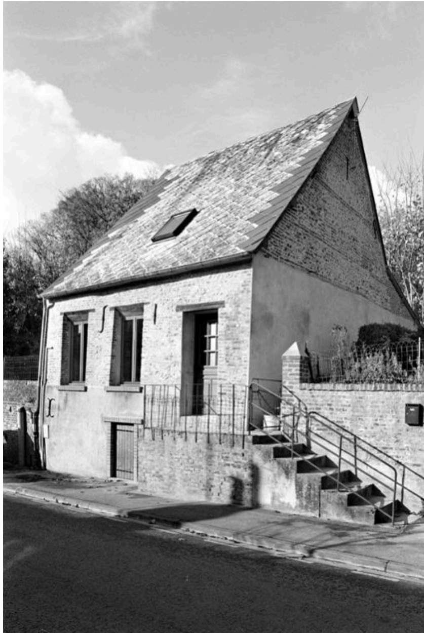
Vue de la façade sur rue et du pignon (en silex et brique).
