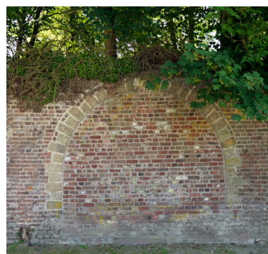
Un ancien portail (muré) est encore visible dans le mur de clôture subsistant au nord, rue du Calvaire. Phot. Marie-Laure Monnehay-Vulliet IVR32_20188000338NUC2A
