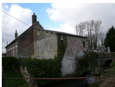
Vue du logis et de ce qu'il reste du moulin à eau. Phot. Inès Guérin IVR22_20078005632NUCA
