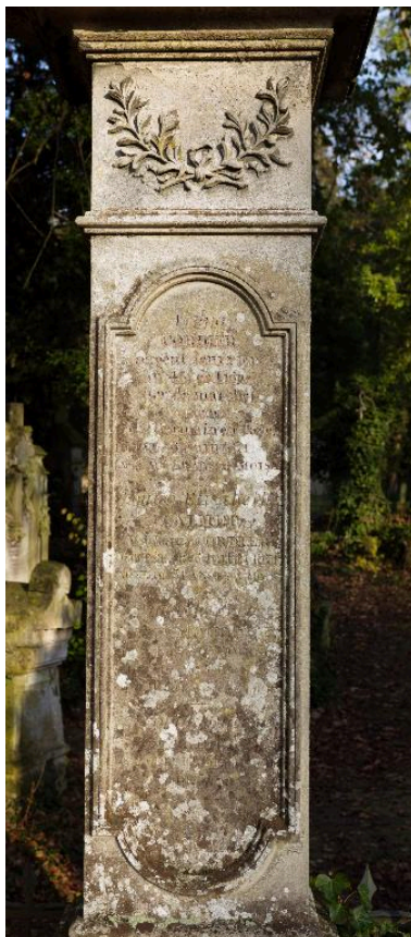
Vue de détail sur le pilier droit de l'arc.
