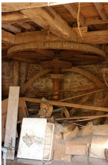
Le beffroi et les mécanismes de transmission du moulin. Phot. Thierry Lefébure IVR22_20036000296NUCA
