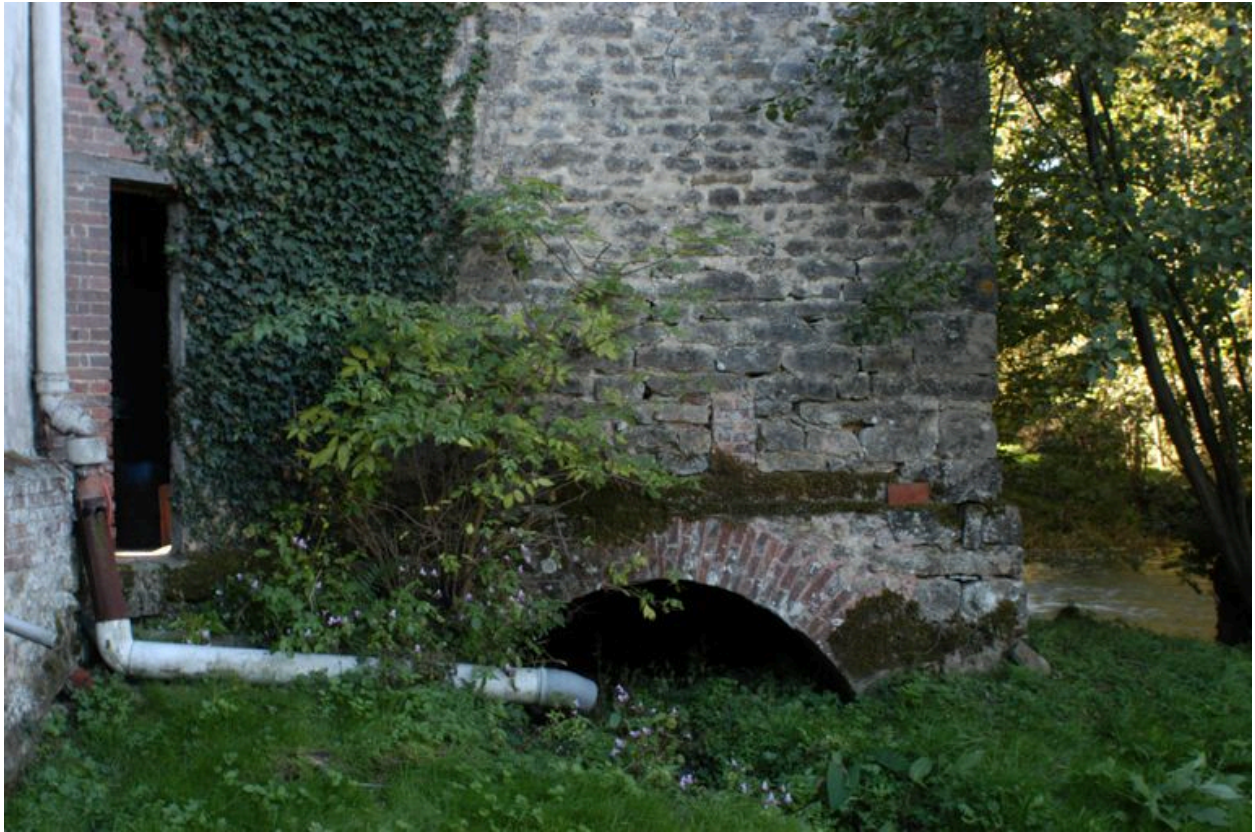
Détail de la coulerie sous cage maçonnée, face est.
