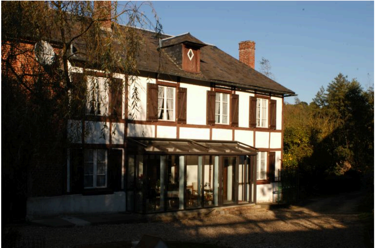
Façade sur cour du logement d'habitation.
