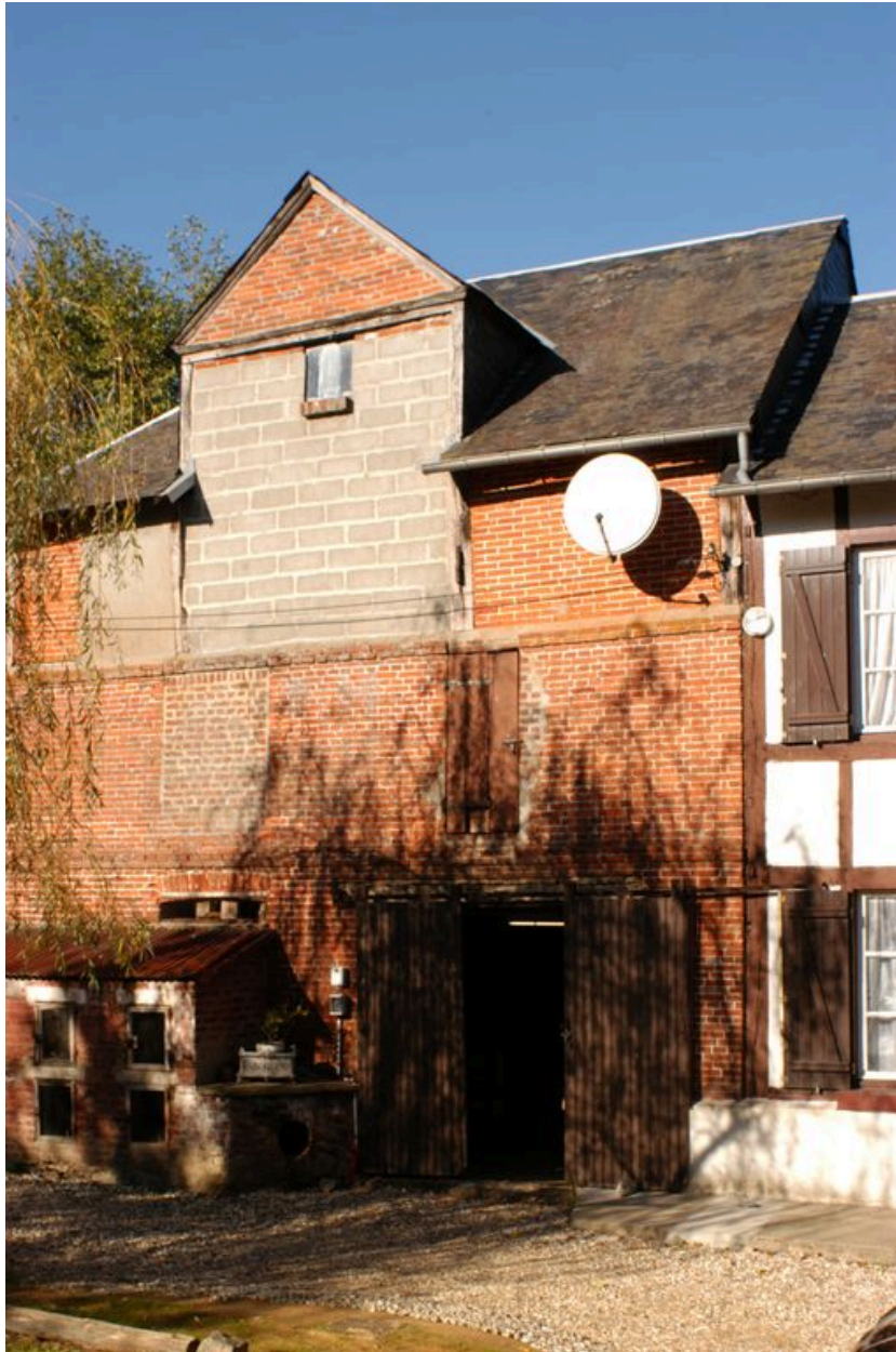
Vue de l'atelier de fabrication, façade sud sur cour.
