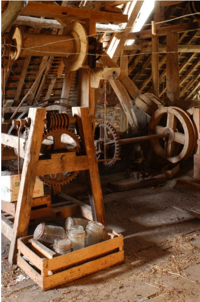
Intérieur du comble, détail du treuil et les mécanismes de transmission supérieurs.
