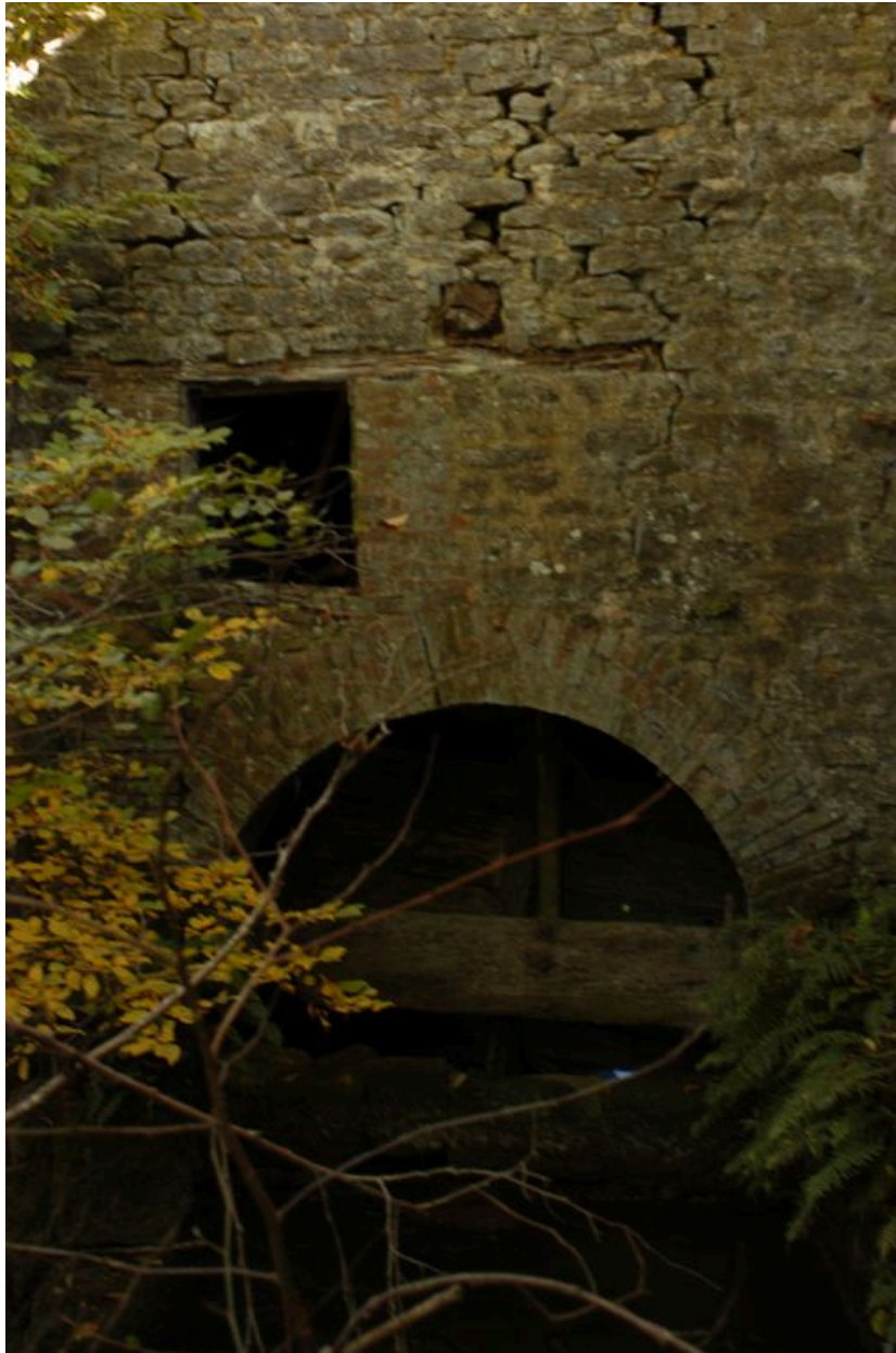
Détail de la coulerie sous cage maçonnée, face ouest.
