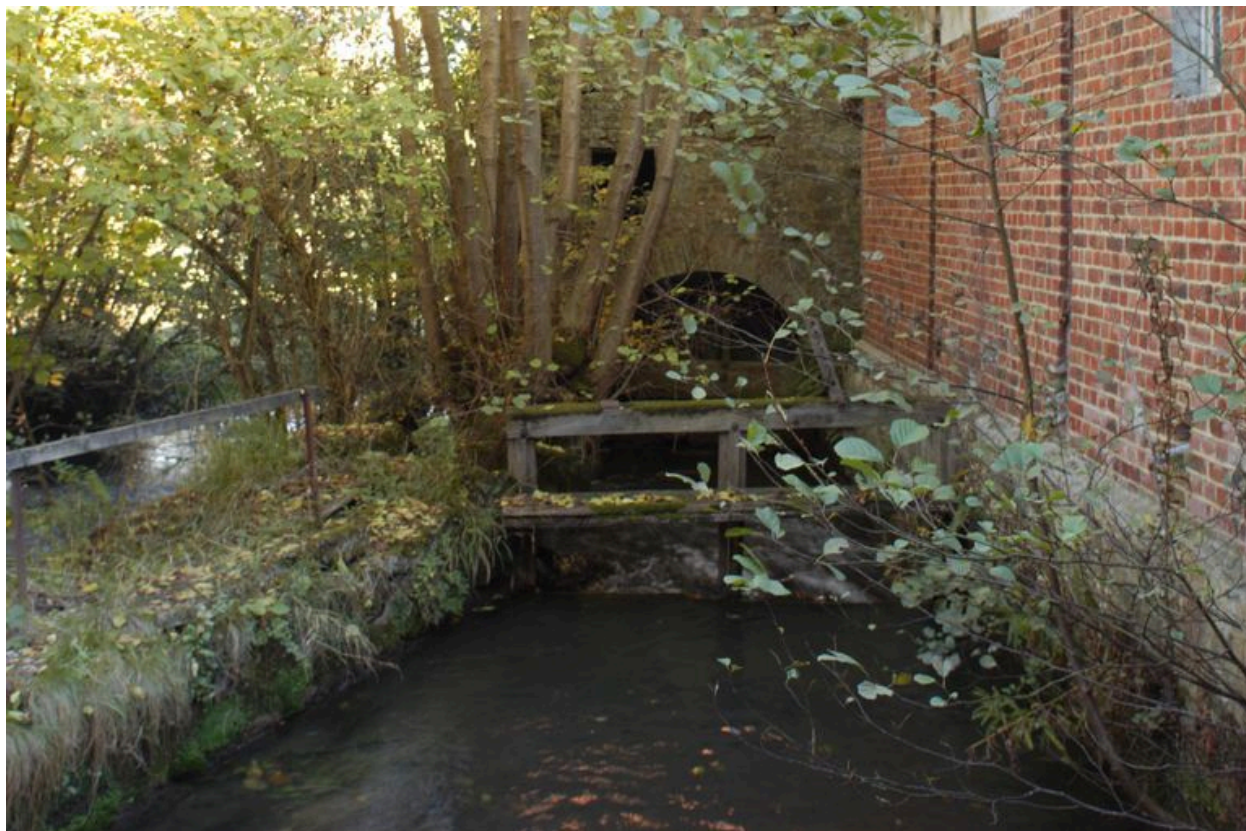
Le canal d'amenée, le vannage et la coulerie sous cage maçonnée, face ouest.
