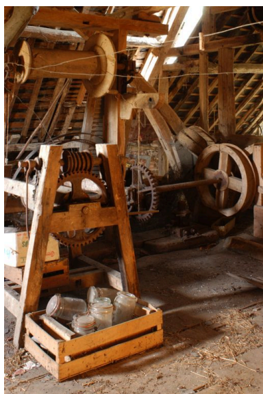
Intérieur du comble, détail du treuil et les mécanismes de transmission supérieurs. Phot. Thierry Lefébure IVR22_20036000298NUCA
