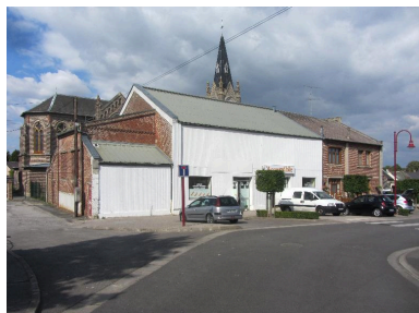
Vue générale depuis le sud-ouest. Phot. Bertrand Fournier IVR32_20160205196NUC2A
