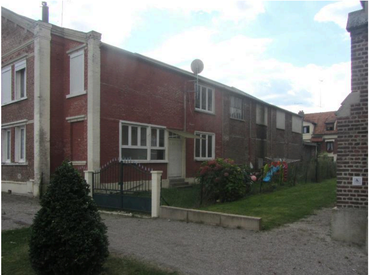
Vue de la façade nord.
