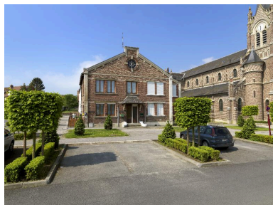
Vue de la façade principale. Phot. Thierry Lefébure IVR32_20160200060NUC2A
