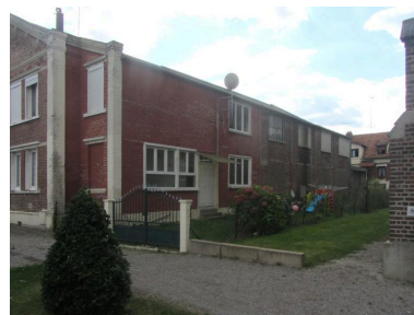
Vue de la façade nord. Phot. Bertrand Fournier IVR32_20160205195NUCA
