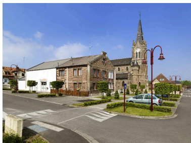
Vue générale de trois-quarts. Phot. Thierry Lefébure IVR32_20160200059NUC2A
