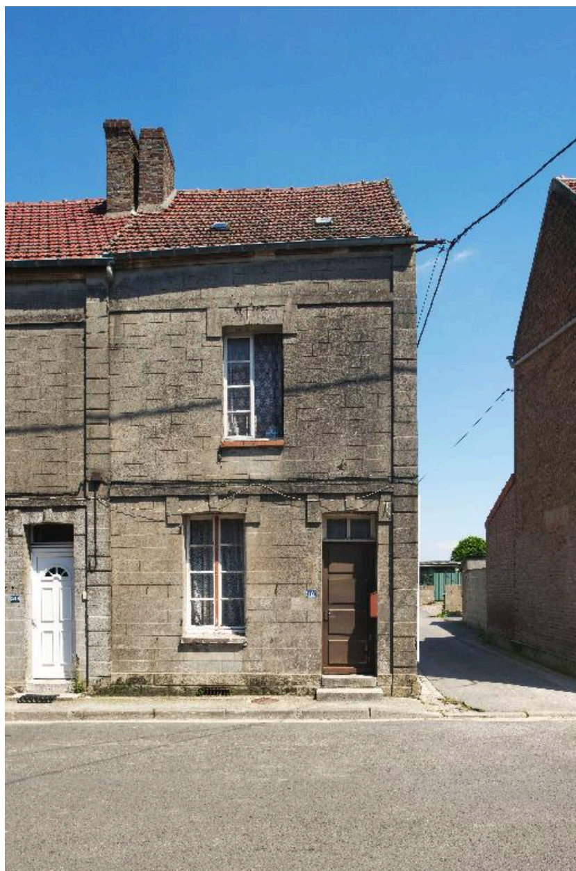
Détail de la façade d'un des logements.
