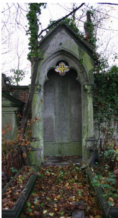
Tombeau en forme de niche monumentale. Phot. Caroline Vincent IVR22_20068001783NUCA
