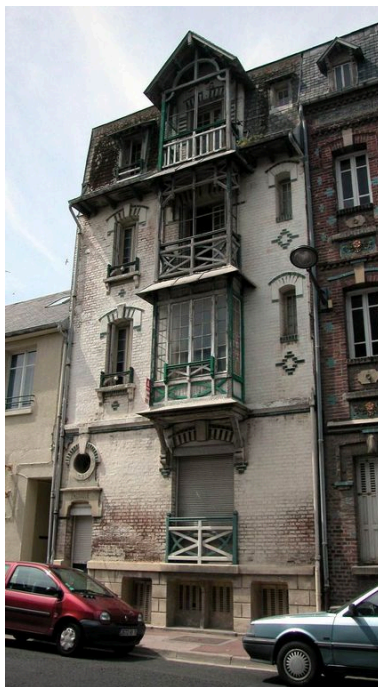
Vue d'ensemble avant travaux (été 2003). Phot. Elisabeth Justome IVR22_20038005294NUCA
