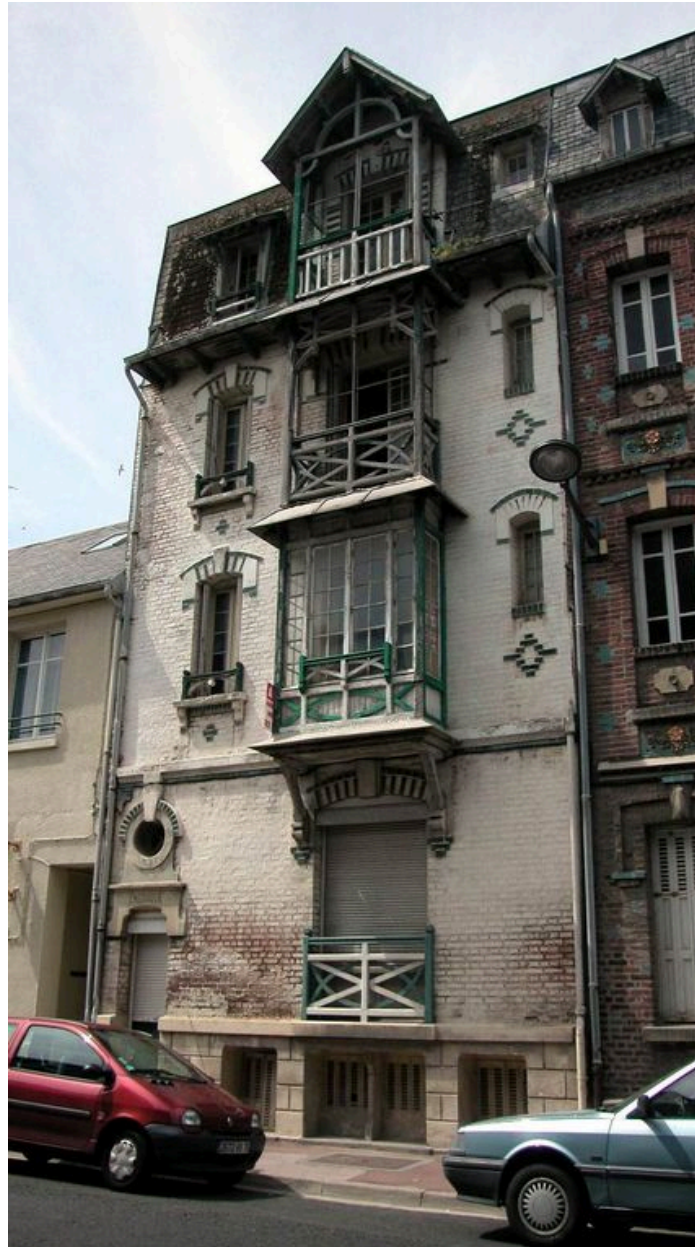
Vue d'ensemble avant travaux (été 2003).
