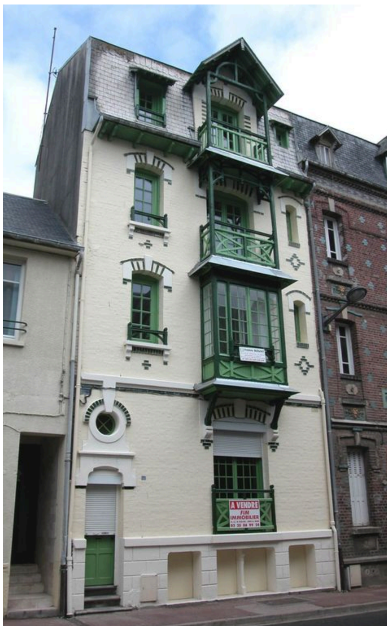
Vue d'ensemble après travaux (printemps 2004).
