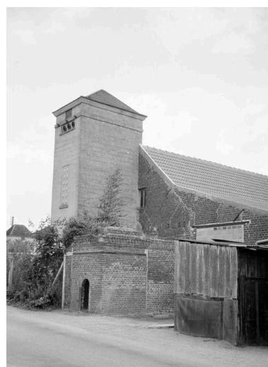
Transformateur électrique. Phot. Benoît Dufournier
