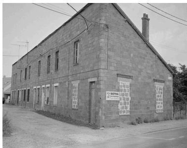
Logements d'ouvriers. Phot. Benoît Dufournier IVR22_19936001634Z
