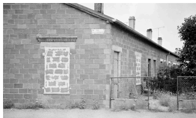
Logements d'ouvriers. Phot. Benoît Dufournier IVR22_19936001633Z
