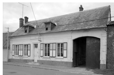
Logis. Elévation sur rue. Phot. Jean-Michel Perrin IVR22_19846001139X
