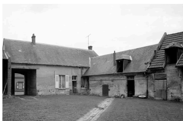
Vue partielle des bâtiments sur cour. Phot. Jean-Michel Perrin IVR22_19846001138X
