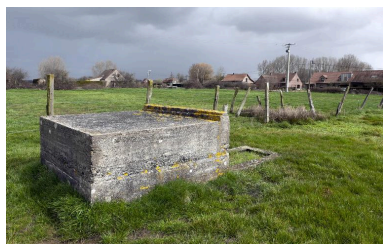
Vue de trois-quarts vers le nord-est Phot. Jean-Marc Ramette IVR31_20145904654NUCA
