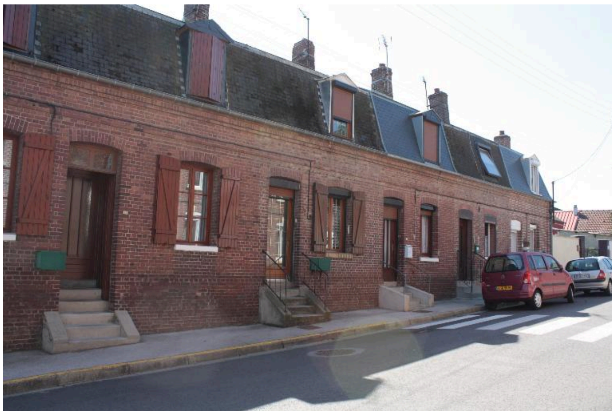
Les maisons ouvrières, rue Ambroise-Croizat.
