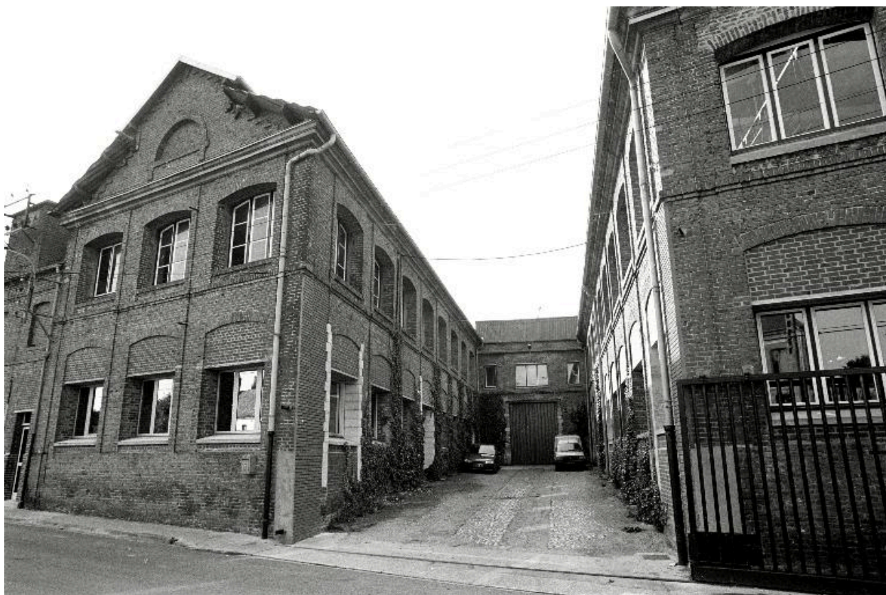
Les anciens ateliers et magasins, construits vers 1895, en 1990.
