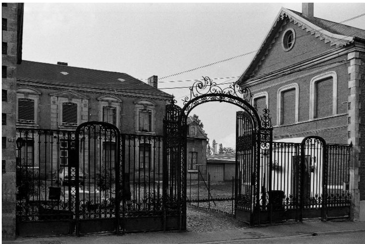
La grille du logement patronal, en 1990.
