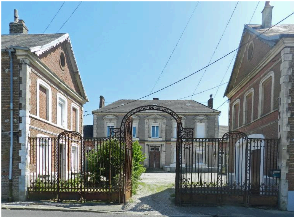
Le logement patronal construit pour Pierre Valery Fournier, vers 1845, depuis la rue Henri-Barbusse.
