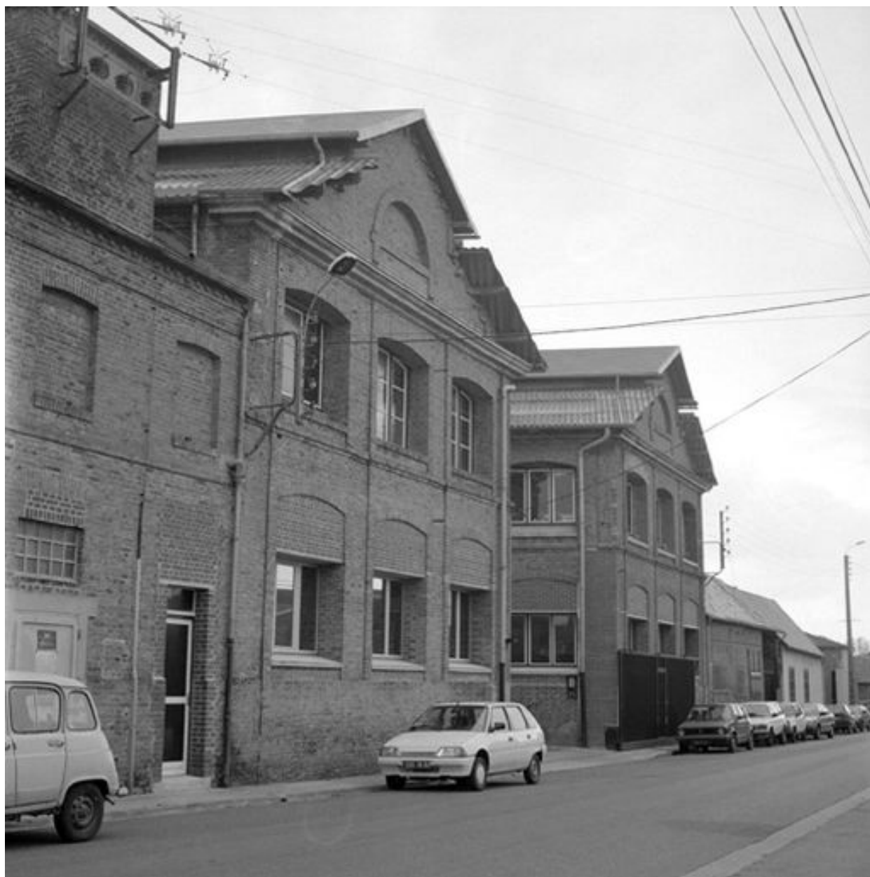
Les anciens ateliers et magasins construits vers 1895, vus depuis la rue Henri-Barbusse, en 1990.
