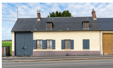
Logis d'une ancienne ferme, n °19 de la rue Saint-Antoine. Phot. Marc Kérignard IVR32_20246000738NUCA
