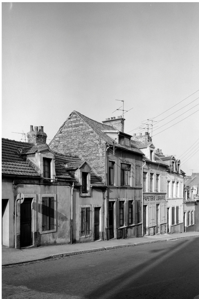
Maison, série de 3, 40 à 44 rue de la Paix, 2e quart 19e siècle.
