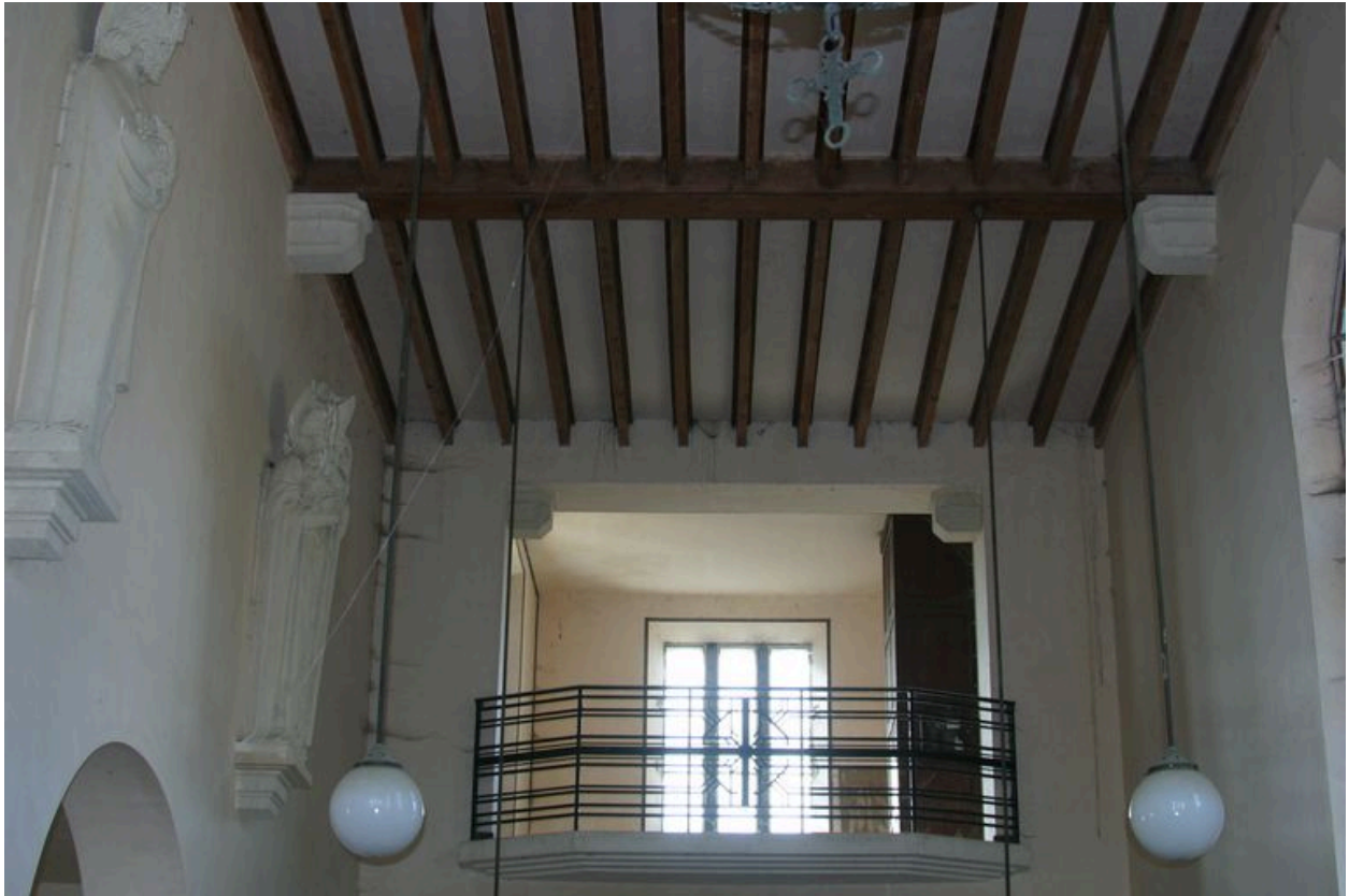
Vue de la tribune et de la charpente.
