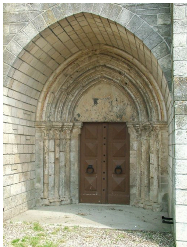
Vue du portail d'entrée datant du 13e siècle. Phot. Inès Guérin IVR22_20030202766NUCA
