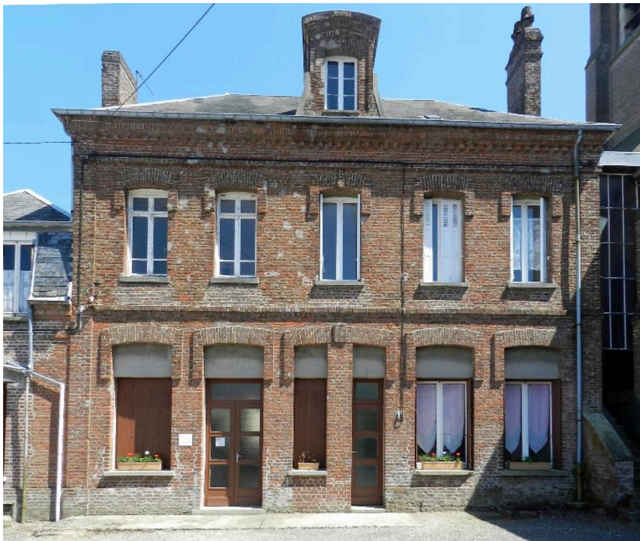
Vue la façade sud de l'ancienne école, du côté de la cour des élèves.
