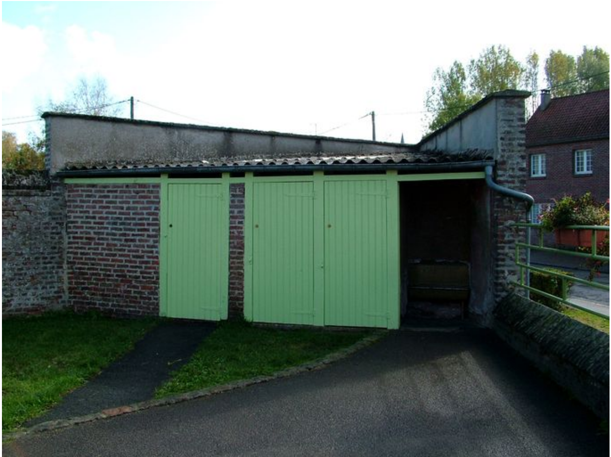
Sanitaires au fond de l'ancienne cour des garçons.
