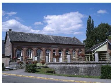
Vue du bâtiment ancien abritant les anciennes classes des garçons et des filles.
