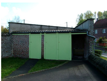
Sanitaires au fond de l'ancienne cour des garçons.
