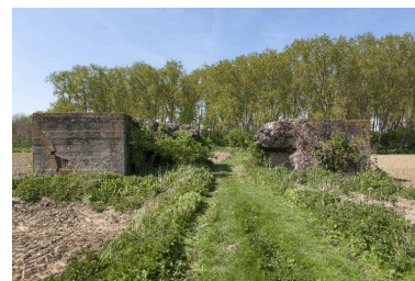
Vue générale vers le nord-ouest Phot. Jean-Marc Ramette IVR31_20145904858NUCA
