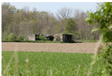
Vue générale vers le nord-est Phot. Jean-Marc Ramette IVR31_20145904854NUCA
