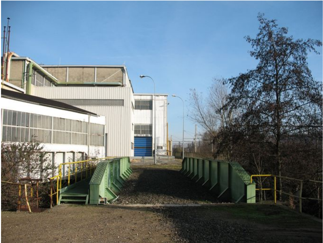
Ancien pont ferroviaire sur le Thérain et reliant les ateliers.
