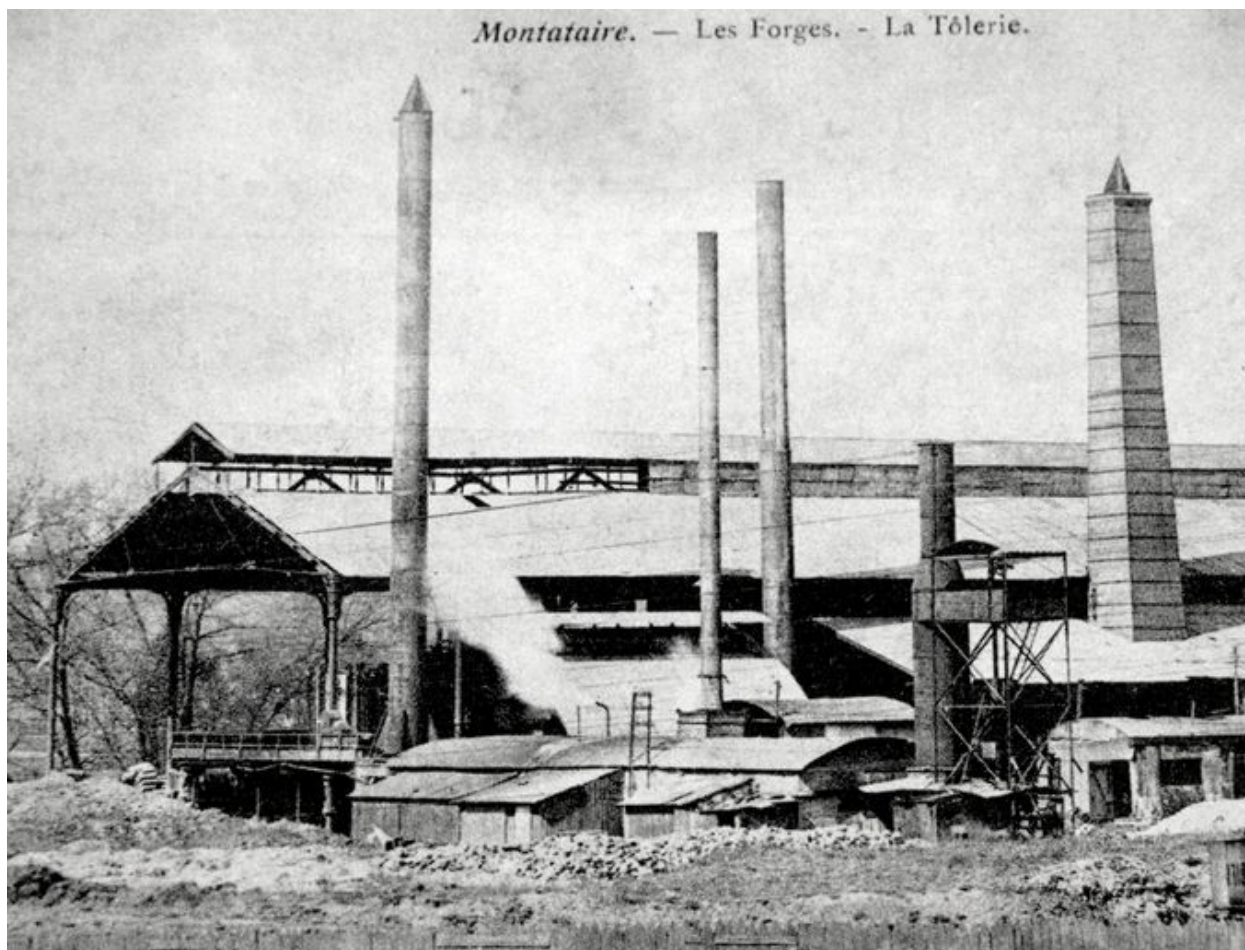
Les ateliers de fabrication : la tôlerie (AC Creil).
