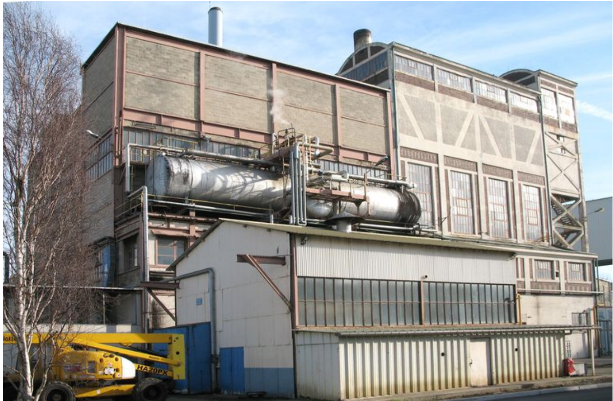
Elévation ouest de la centrale vapeur.
