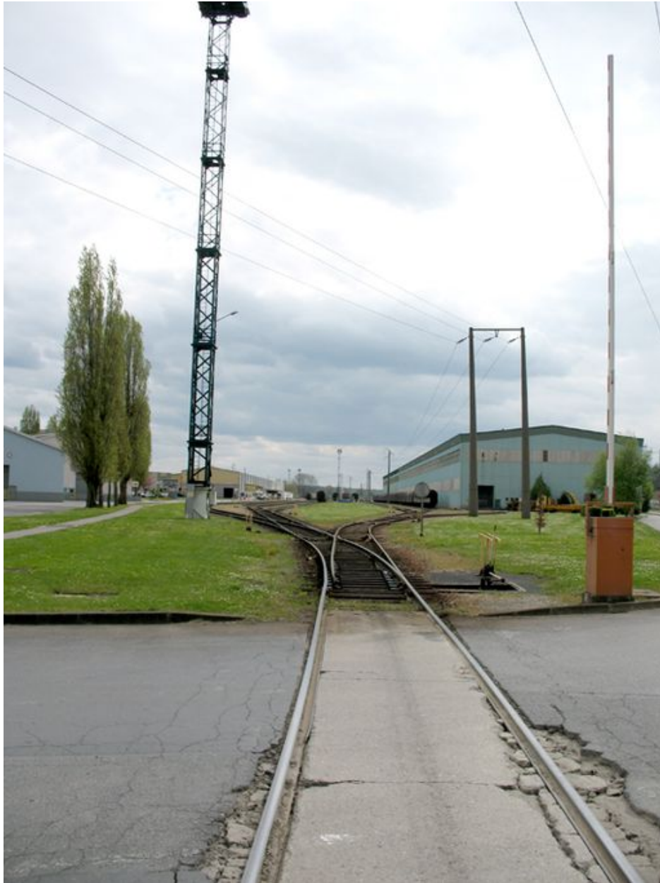
Voies ferrées au centre du site et desservant les ateliers.
