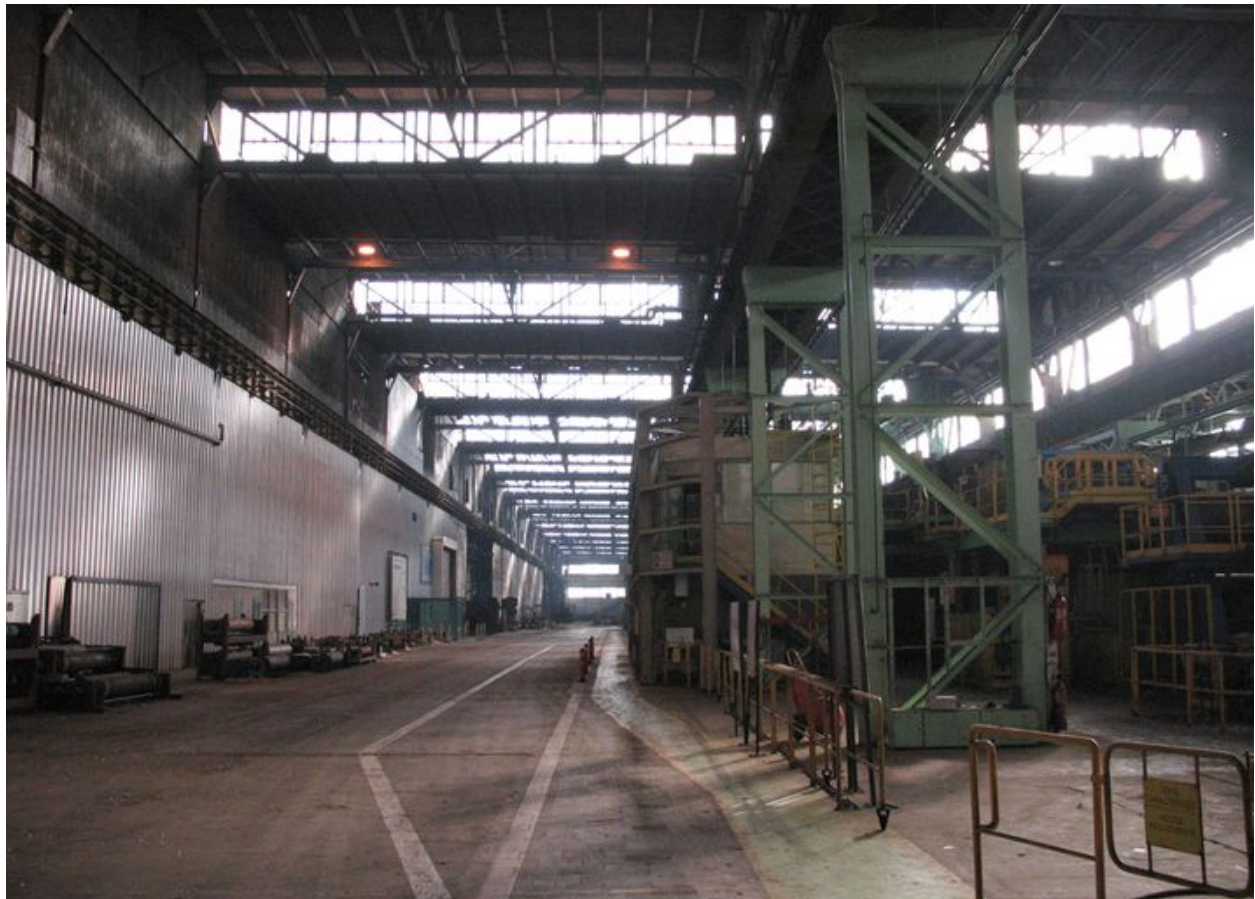
Ligne de décapage (à l'arrêt).
