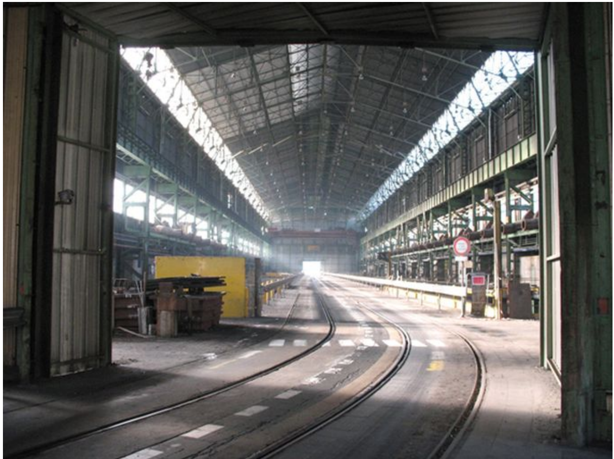
Passage couvert entre les ateliers du recuit et les lignes de galvanisation.
