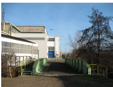
Ancien pont ferroviaire sur le Thérain et reliant les ateliers. Phot. Clarisse Lorieux IVR22_20086005143NUCA
