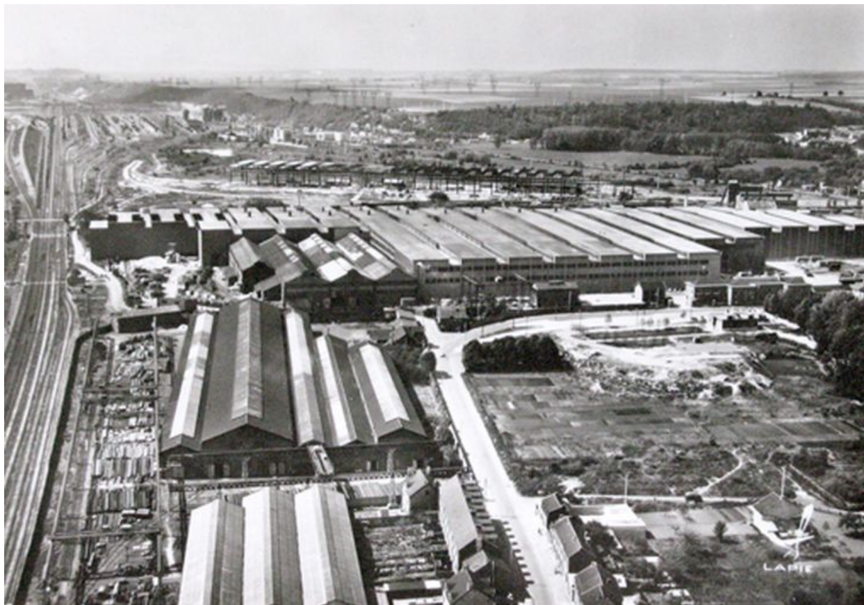
Vue des ateliers d'Usinor vers 1950 (AC Montataire).
