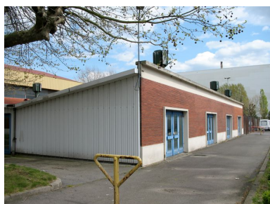
Garage à vélos construit en 1957 face à l'entrée de l'usine. Phot. Clarisse Lorieux IVR22_20086005160NUCA
