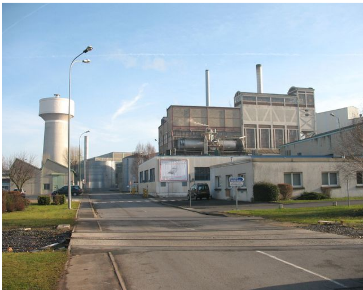
A droite la centrale thermique construite en 1929-1930, à gauche le château d'eau élevé en 1949.
