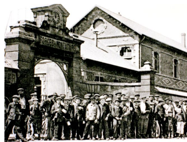
Entrée des forges de Montataire au début du 20e siècle (AC Creil). Phot. Clarisse Lorieux IVR22_20076005427NUCAB
