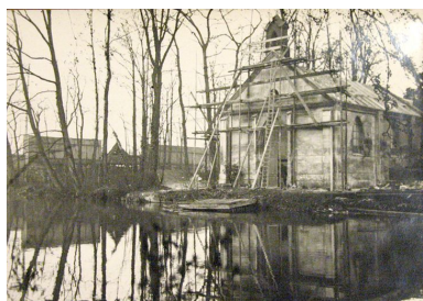
Restauration du toit de la chapelle en 1949 (archives d'entreprise). Phot. Clarisse Lorieux IVR22_20086005007NUCAB
