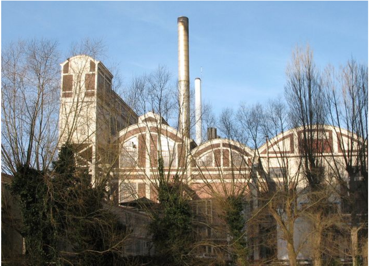
Elévation de la centrale vapeur, façade sud.
