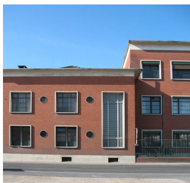
Détail de la façade des bureaux.
