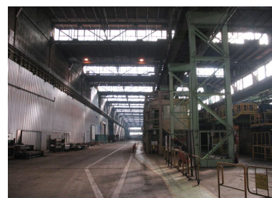
Ligne de décapage (à l'arrêt).
