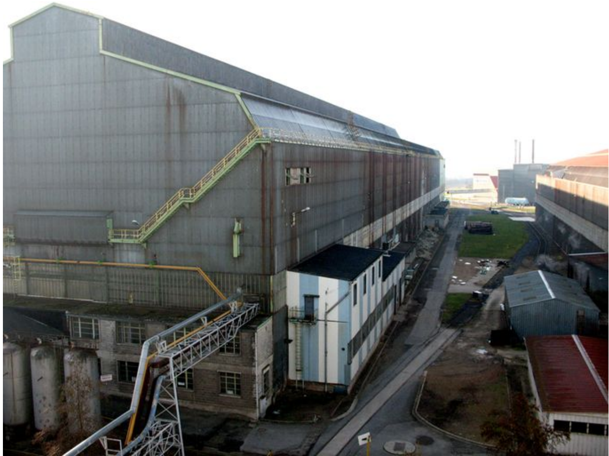
Atelier de stockage et rails.
