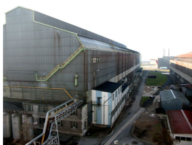
Atelier de stockage et rails. Phot. Clarisse Lorieux IVR22_20086005145NUCA
