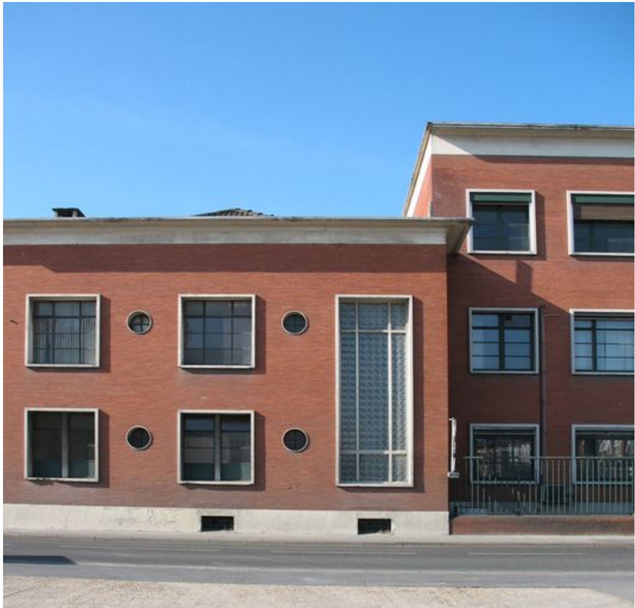
Détail de la façade des bureaux.
