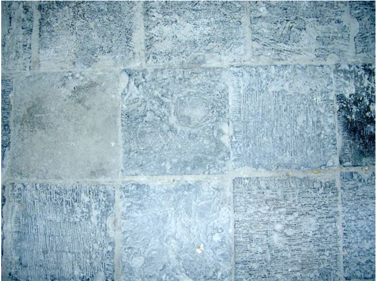
Dalles de la chapelle des Forges réemployées pour le sol de l'église.
