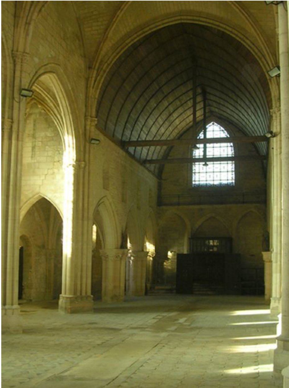
Nef centrale de l'église de Montataire où le dallage de la chapelle a été réemployé.
