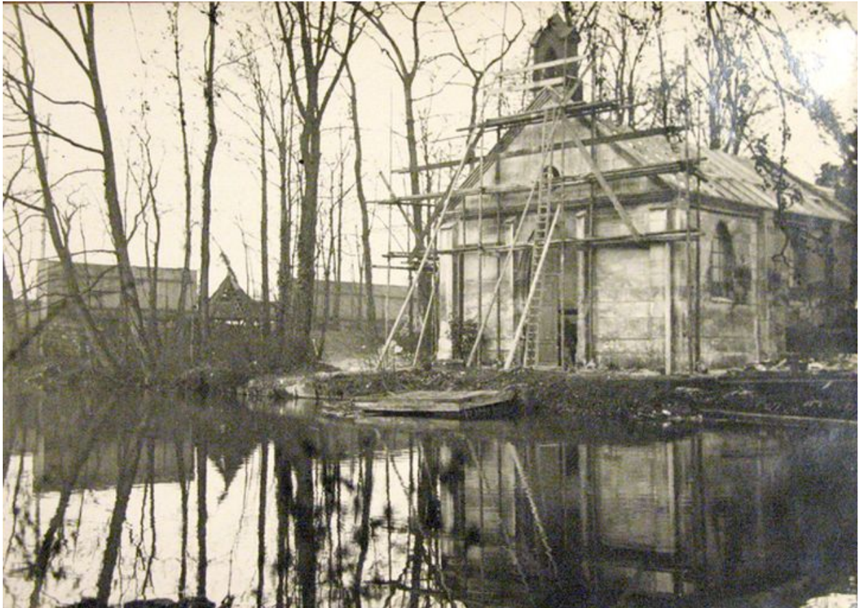
Restauration du toit de la chapelle en 1949 (archives d'entreprise).
