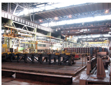
Atelier abritant le laminoir : rectifieuses et skin-pass (à l'arrêt).
