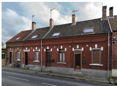
Logements ouvriers, 73 à 79 rue Eugène-Létocart. Phot. Marie-Laure Monnehay-Vulliet IVR22_20148000104NUC2A
