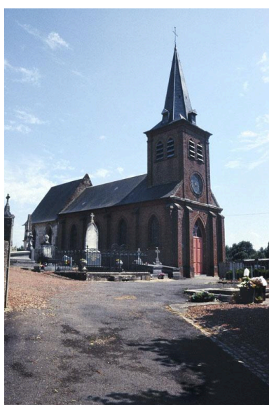
Vue de la façade occidentale et du flanc nord. Phot. Frédéric Fournis IVR22_20030200781ZA
