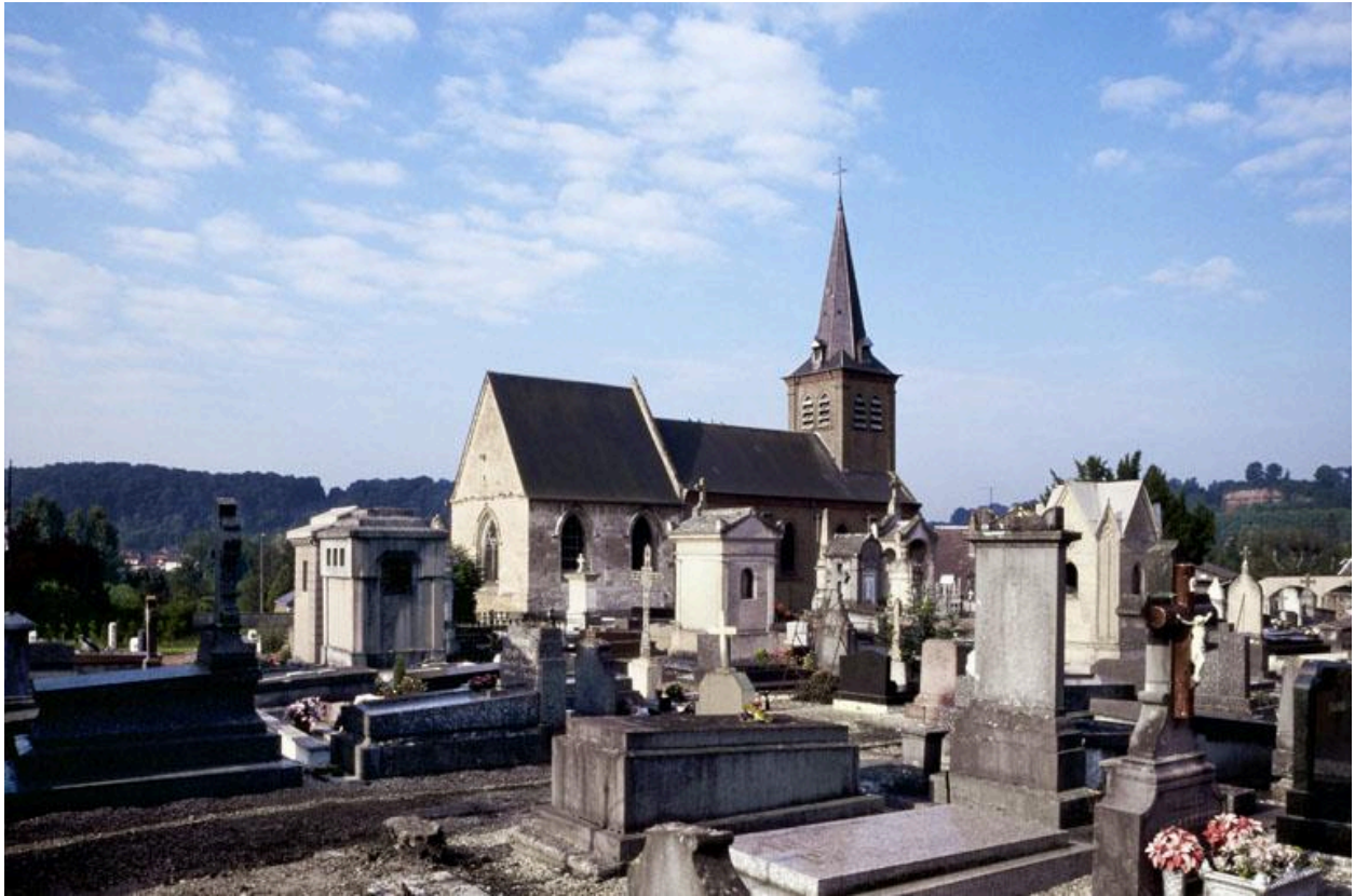
Vue générale de l'église et de son cimetière, prise depuis le nord-est.
