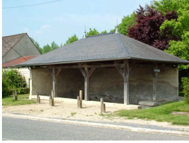
Vue générale. Phot. Inès Guérin IVR22_20030202389NUCA
