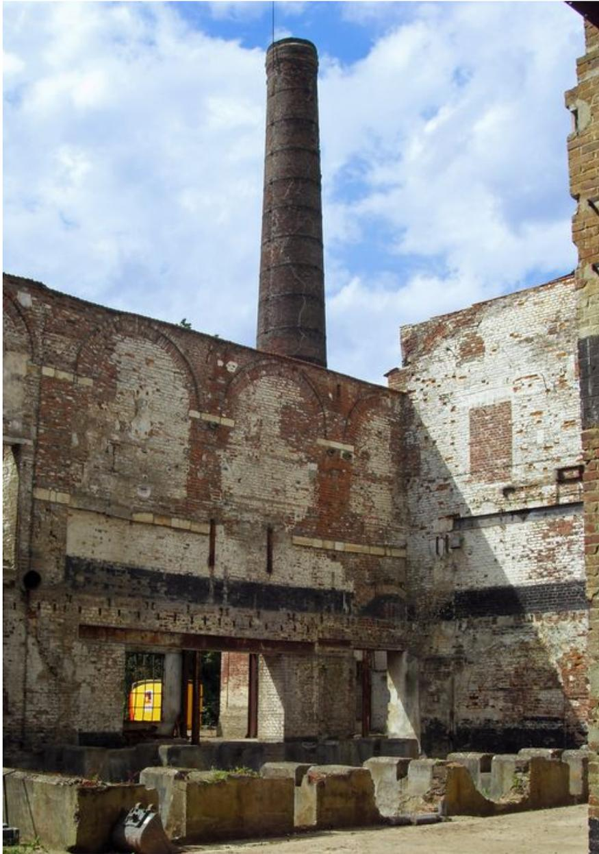
Partie supérieure du grand atelier de diffusion, élévation intérieure ouest, portant les traces des anciennes ouvertures supérieures.
