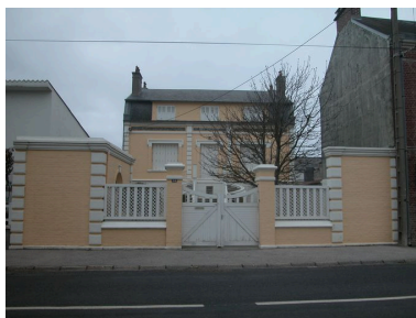
Vue d'ensemble depuis la rue du Général-Leclerc. Phot. Elisabeth Justome IVR22_20058002684NUCA
