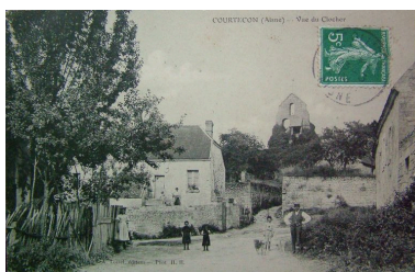
Vue de l'ancienne église de Courtecon (coll. part). Phot. Inès Guérin IVR22_20050200450NUCAB
