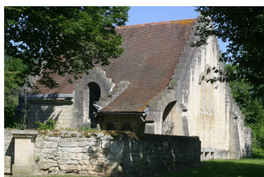
Vue latérale. Phot. Inès Guérin IVR22_20030202796NUCA
