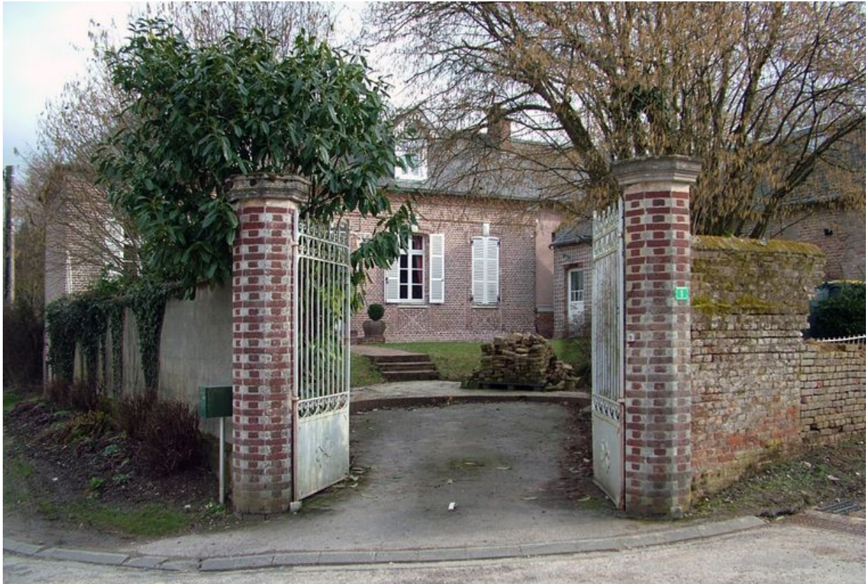
Vue générale avec le portail et la cour.
