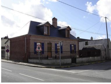
Vue générale. Phot. Inès Guérin IVR22_20058005263NUCA
