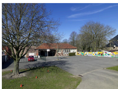
Cour et bâtiment abritant la salle de classe maternelle. Phot. Thierry Lefébure IVR22_20158000105NUC2A
