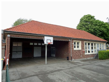
Le bâtiment de la classe maternelle depuis la cour de récréation. Phot. Romain Grimaud IVR22_20138015787NUCA
