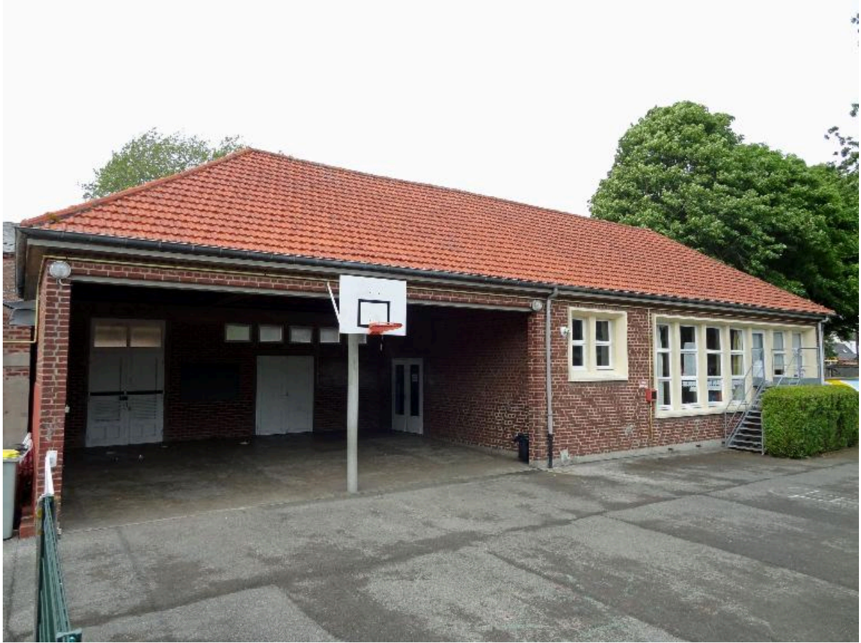
Le bâtiment de la classe maternelle depuis la cour de récréation.
