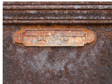
Détail sur la signature : Gorrillon(serrurier). Phot. Isabelle Barbedor IVR22_20038010641NUCA
