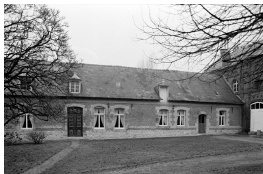
Vue partielle de la façade du logis. Phot. Christiane Riboulleau IVR22_19960200358Z
