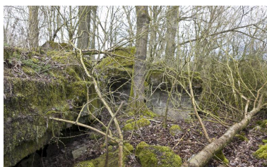
Elévation nord-est. Phot. Jean-Marc Ramette IVR31_20145904413NUCA
