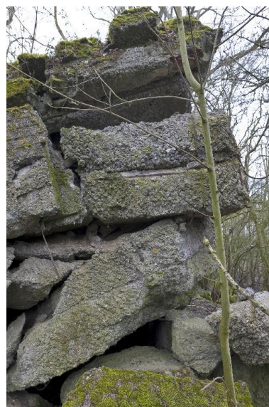
Elévation nord-est. Détail de la structure du béton armé Phot. Jean-Marc Ramette IVR31_20145904416NUCA
