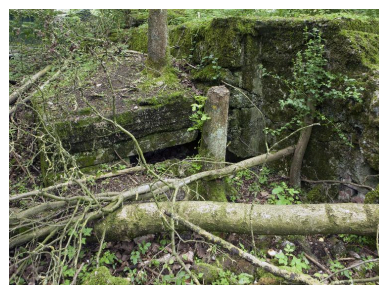
Elévation nord-est. Phot. Jean-Marc Ramette IVR31_20145904410NUCA
