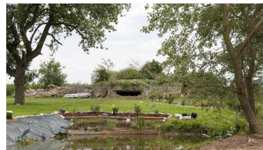
Vue générale vers sud-est Phot. Jean-Marc Ramette IVR31_20145905381NUCA
