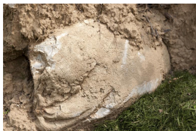
Sac de ciment, à la base de l'édifice. Utilisé couramment pour renforcer ou protéger une position Phot. Jean-Marc Ramette IVR31_20145905387NUCA
