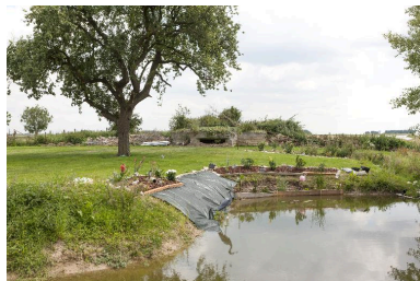
Vue générale vers sud-est Phot. Jean-Marc Ramette IVR31_20145905384NUCA
