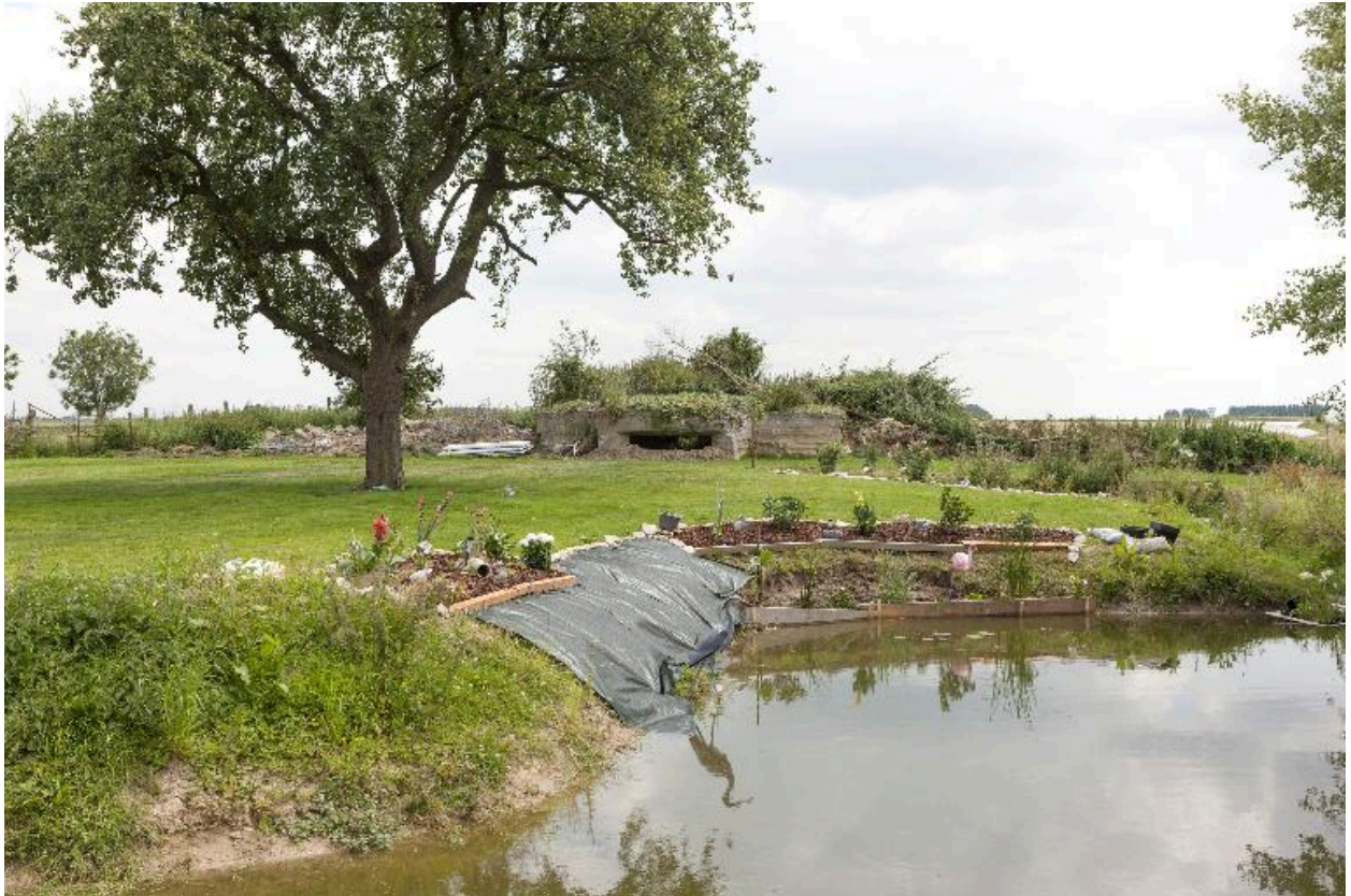
Vue générale vers sud-est
