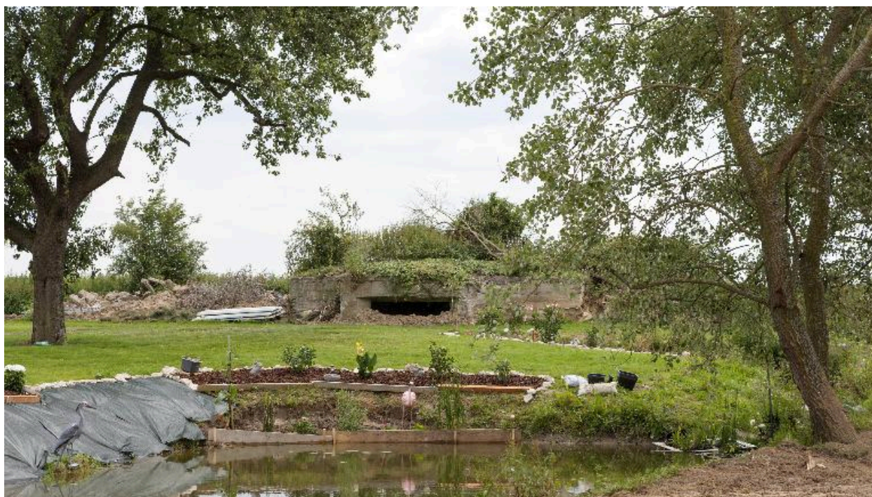
Vue générale vers sud-est
