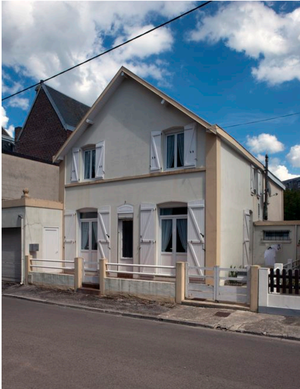
Façade du 5 rue Chambon.
