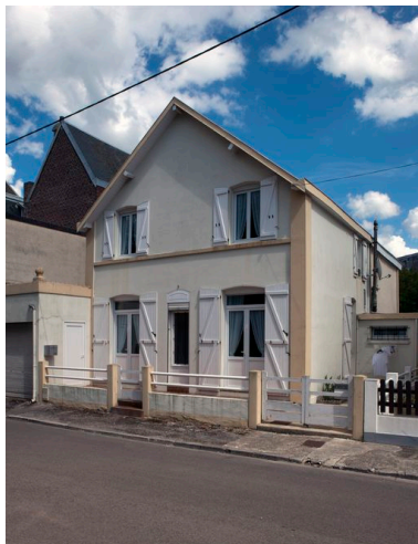
Façade du 5 rue Chambon.
