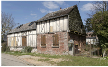
Logis sur rue avec traitement ornemental du pan de bois au-dessus d'une baie, n°64 rue Principale, vue depuis le sud-ouest. Phot. Marc Kérignard IVR32_20216000227NUCA
