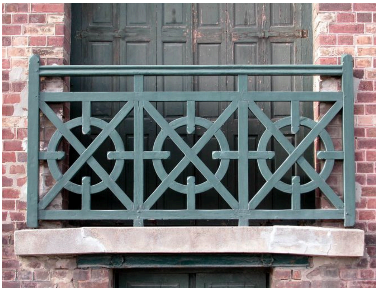
Détail du balconnet en menuiserie du rez-de-chaussée.
