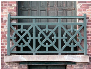
Détail du balconnet en menuiserie du rez-de-chaussée. Phot. Elisabeth Justome IVR22_20048001396NUCA
