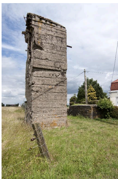
Vue de trois-quarts de l'observatoire, vers l'est Phot. Jean-Marc Ramette IVR32_20165901036NUCA
