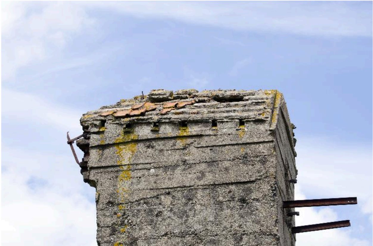
Vue couverture de l'observatoire, vers le nord-est. On aperçoit les deux embrasures d'observation près du faîtage.
