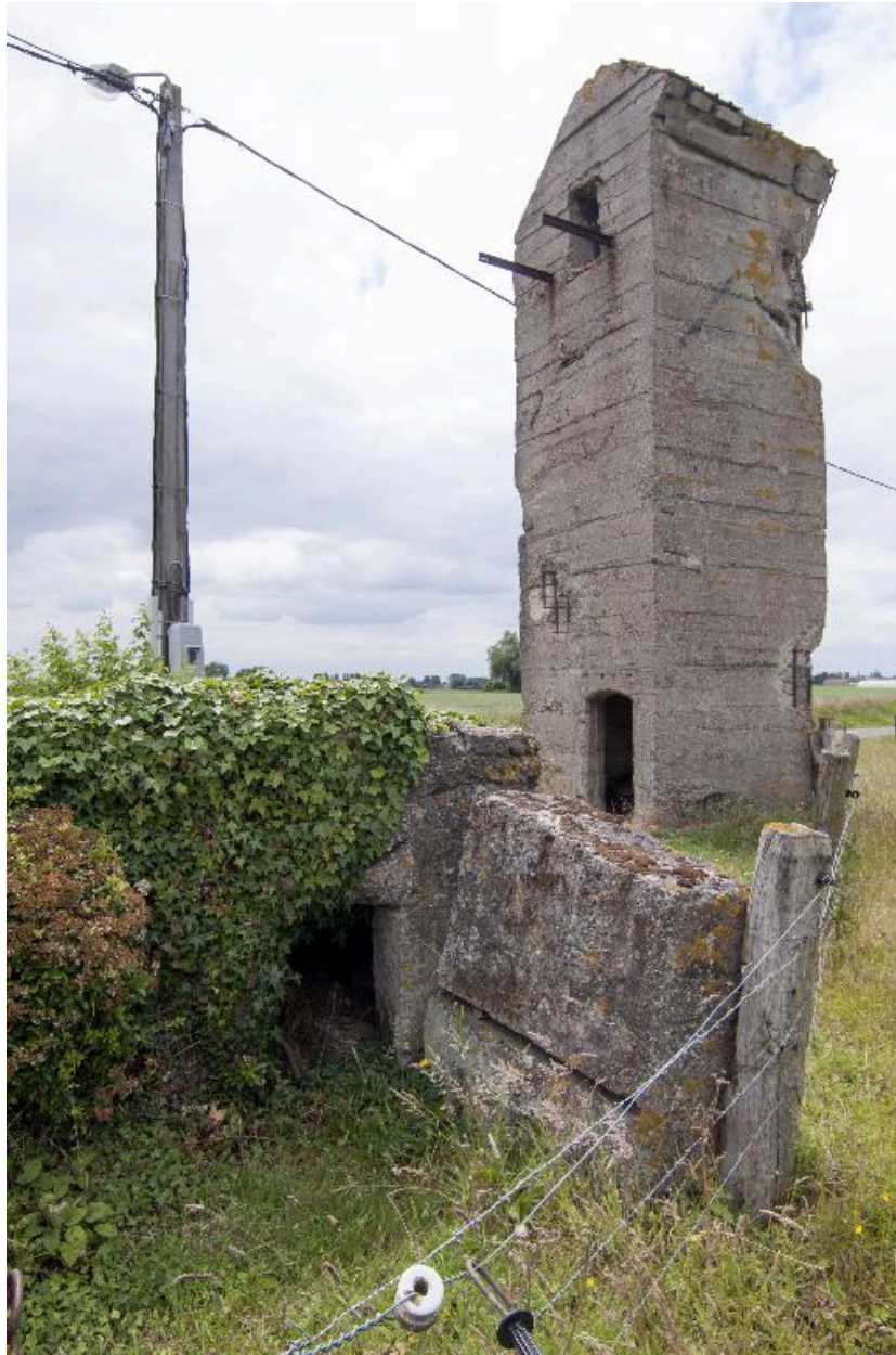
Vue générale des deux casemates, vers l'ouest
