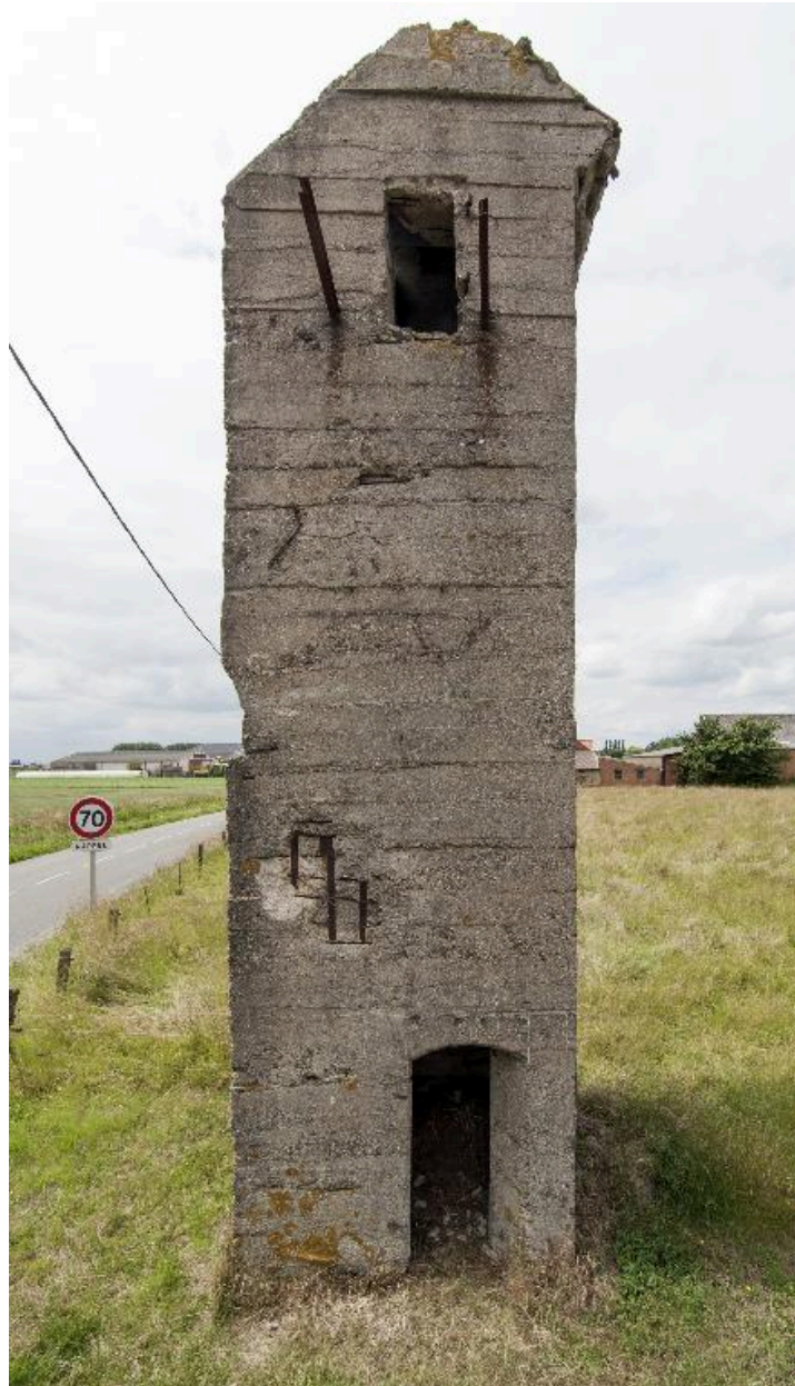
Vue frontale de l'observatoire vers le nord-ouest
