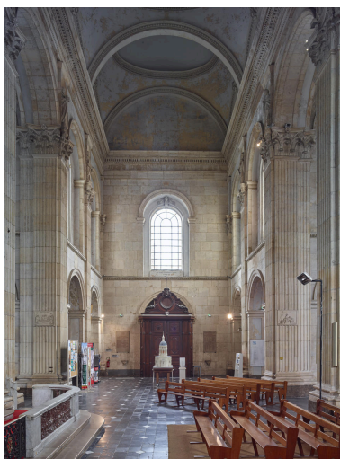
Vue du bras sud du transept, vers l'entrée. Phot. Pierre Thibaut IVR32_20236200244NUCA
