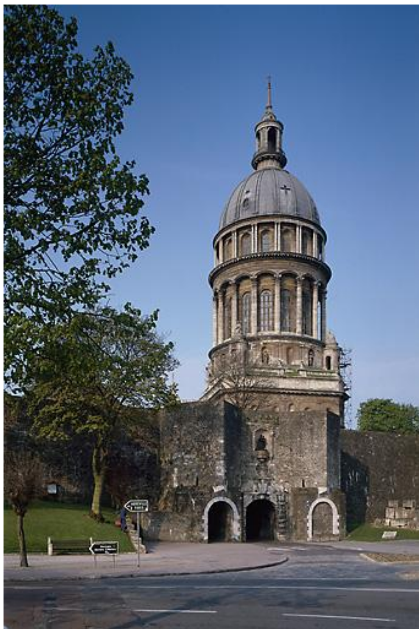
Basilique, porte de Calais, façade est, vue des boulevards.
