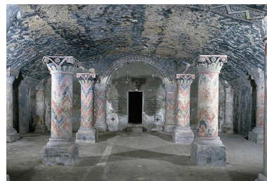
Vue de la crypte romane avant restauration. Phot. Jean-Michel Périn IVR31_19876202074XA
