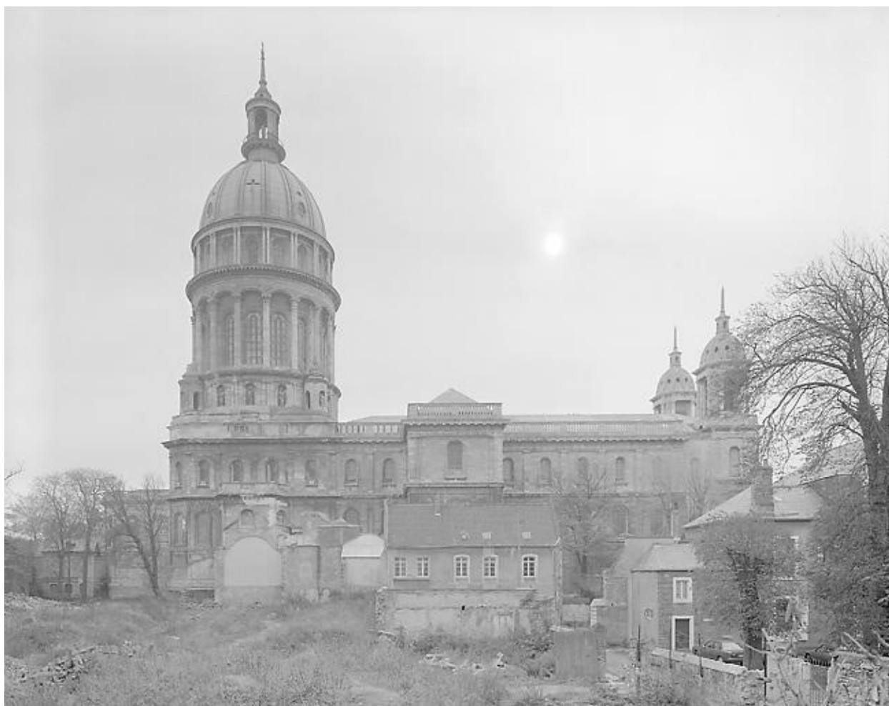
Basilique, façade nord, vue générale.
