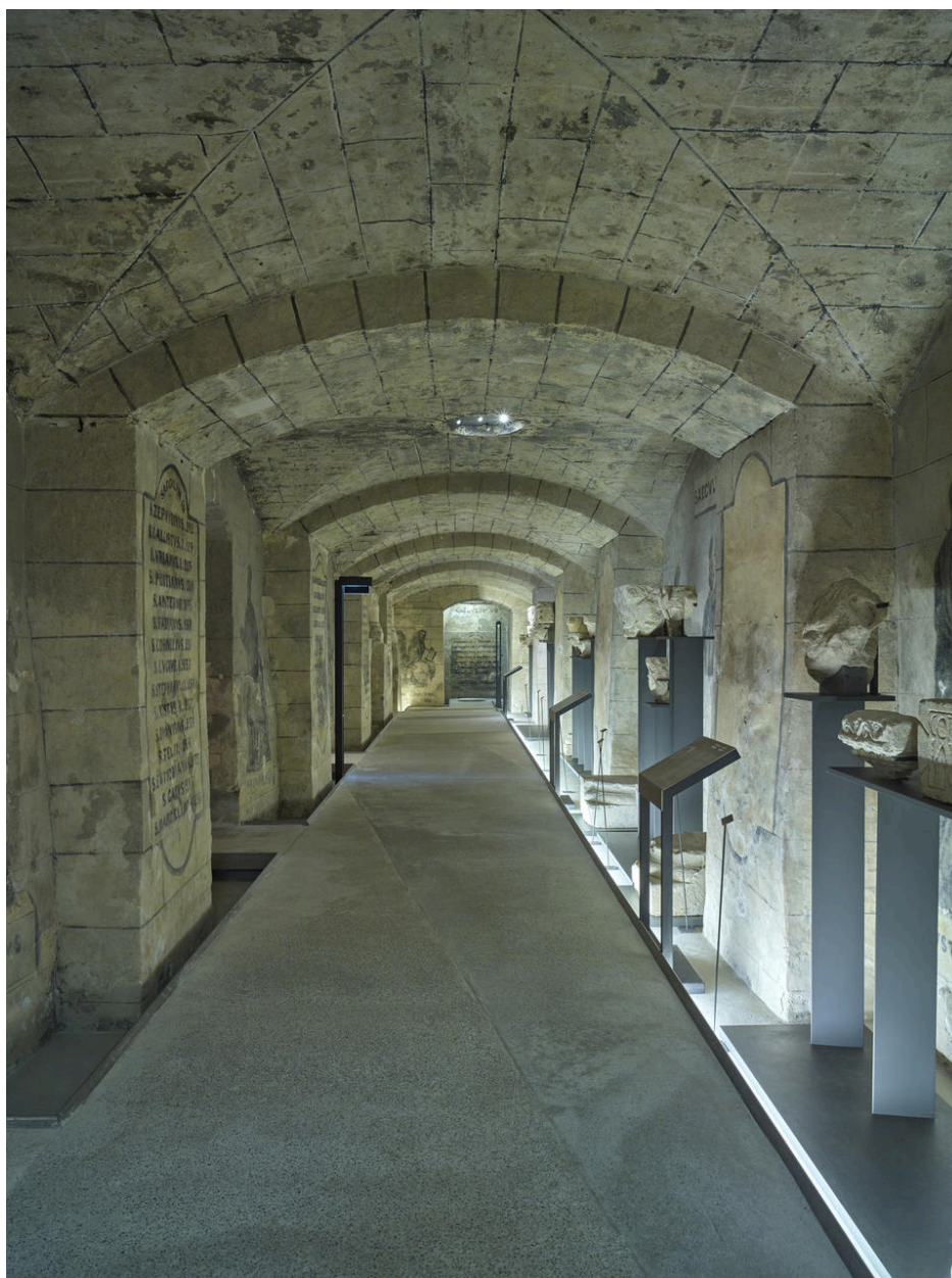
Vue de la galerie sud de la crypte après restauration.
