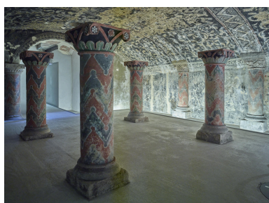
Vue de la crypte romane restaurée. Phot. Pierre Thibaut IVR32_20236200253NUCA
