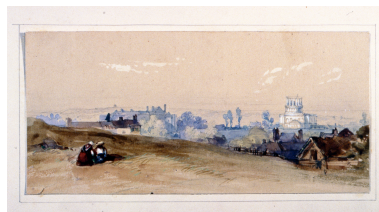
Basilique en cours de construction, vue éloignée ouest, dessin G. Stubbs (collection privée). Repro. Philippe Caudroit IVR31_19806200602ZA
