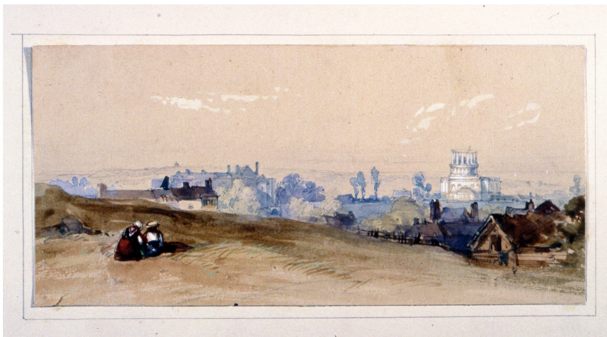
Basilique en cours de construction, vue éloignée ouest, dessin G. Stubbs (collection privée).
