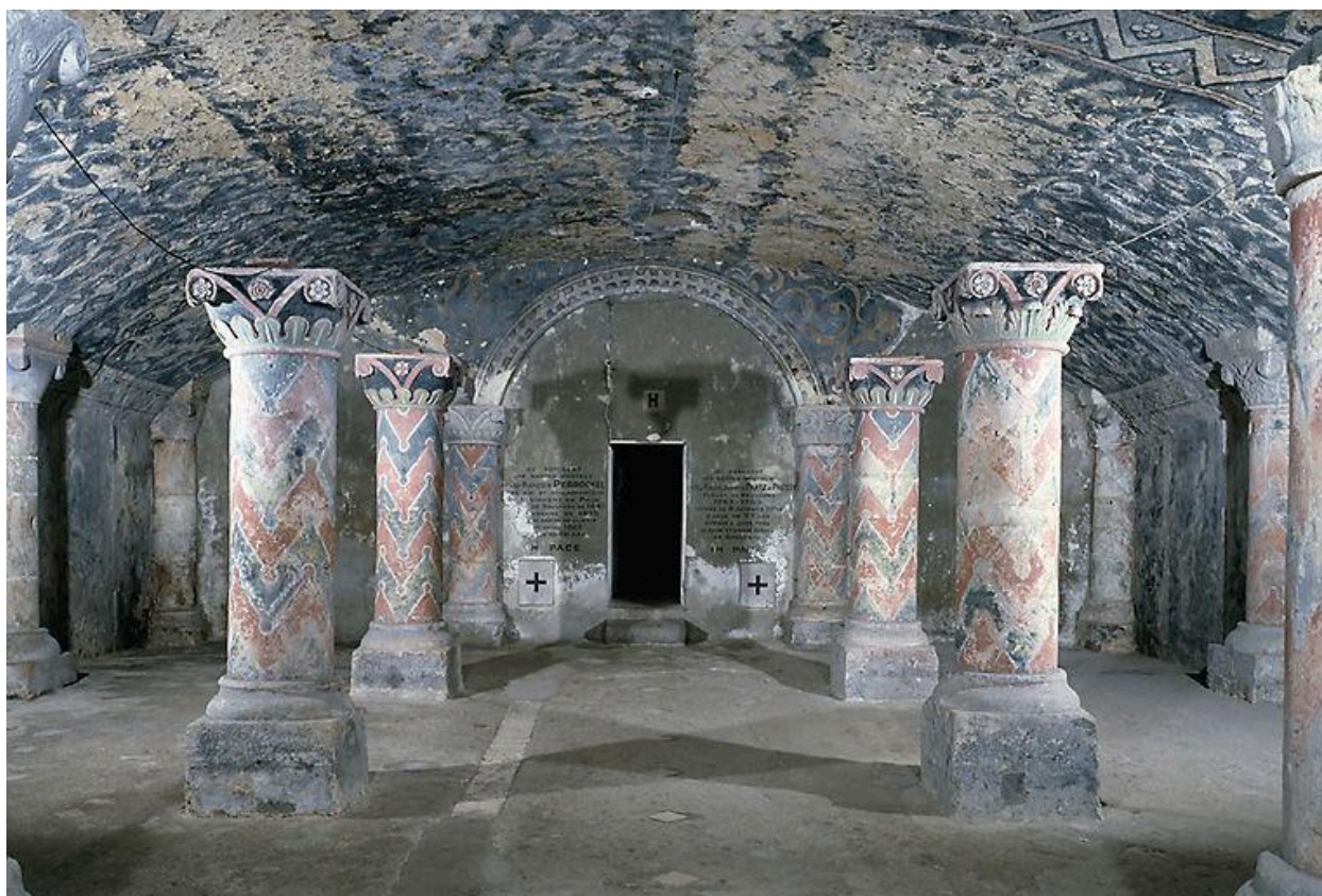
Vue de la crypte romane avant restauration.
