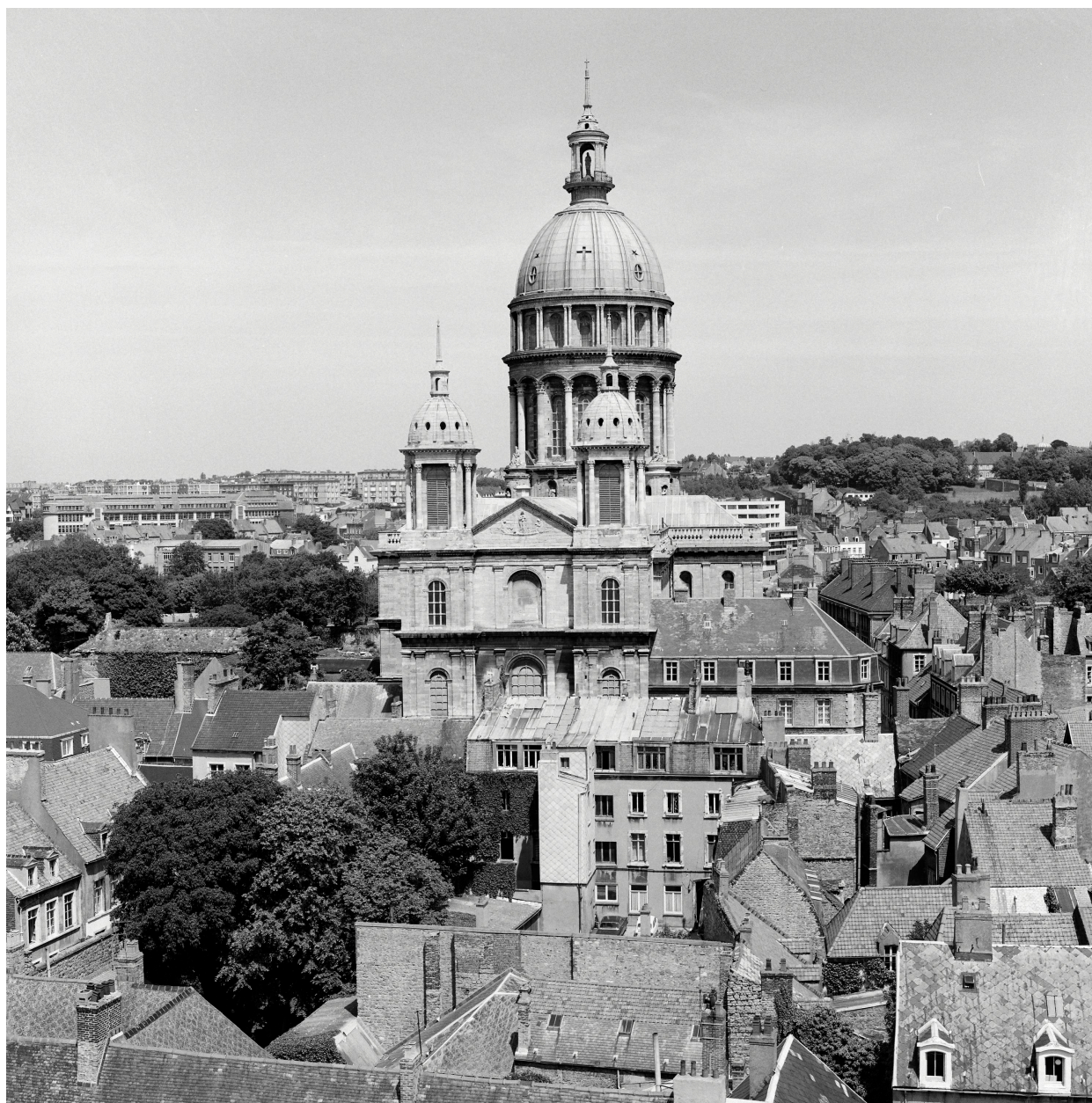
Basilique, vue d'ensemble sud-ouest.
