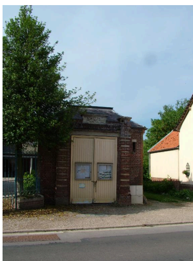
La remise de la pompe à incendie. Phot. Frédéric Fournis IVR22_20108010082NUCA
