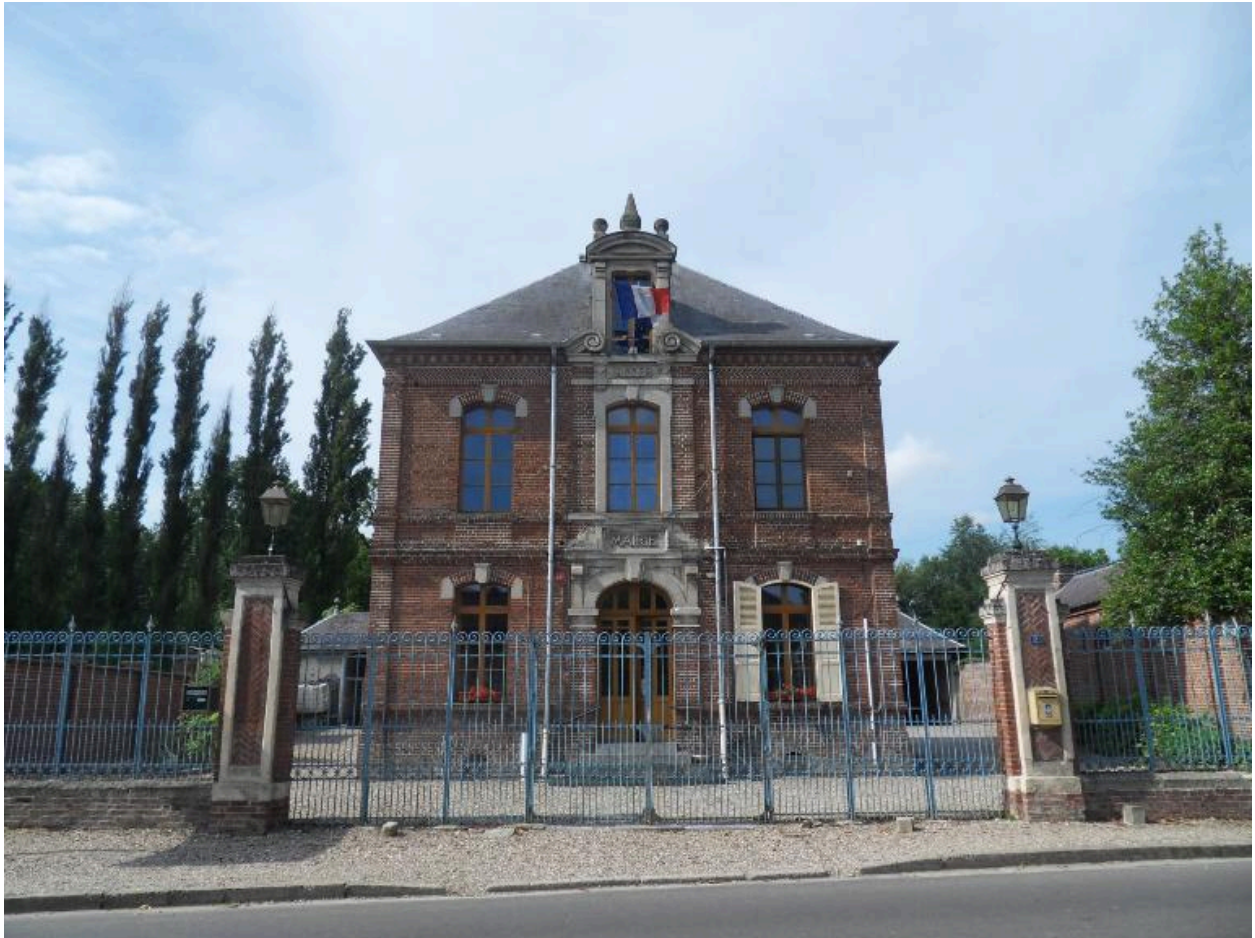
La mairie et l'ancien logement de l'instituteur.
