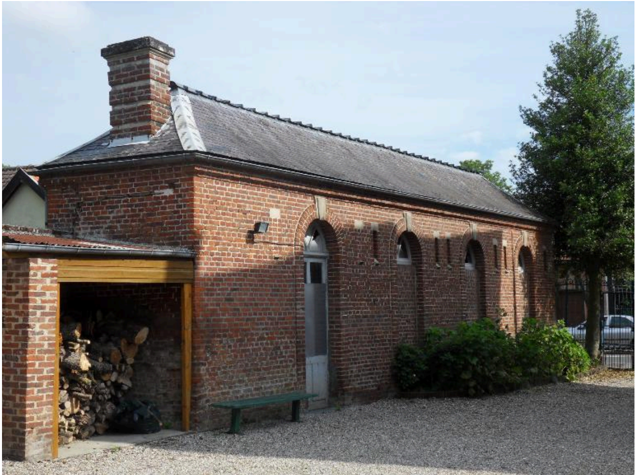
La remise de la pompe à incendie.
