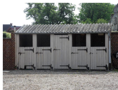
Les latrines. Phot. Isabelle Barbedor IVR22_20108010044NUCA
