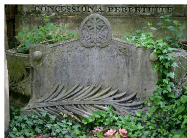
Détail de la jardinière à plantes antérieure, agrémentant le tombeau-monument. Phot. Caroline Vincent IVR22_20088000656NUCA
